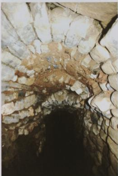
Abb. 13: Kanal unter Stiegegasse 1 mit abgetreppter Gewölbe- konstruktion aus Bruchsteinen. Rechts oben eine mit einer Platte verschlossene Öffnung eines Reinigungsschachtes
