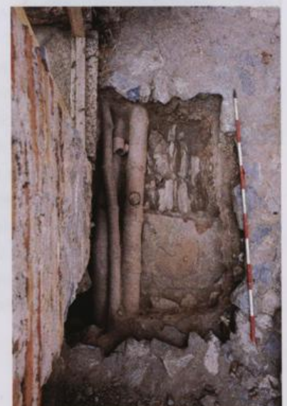
Abb. 17: Sondage in Stiegegasse 1 mit Draufsicht auf einen Kanaldeckel über einem Revisionschacht. Links daneben die Wasserzuleitungsrohre zu den östlichen Wohnungen des Hanghauses 2
