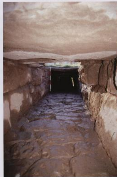
Abb. 32: Abwasserkanal unter der Agora mit flacher Decke
