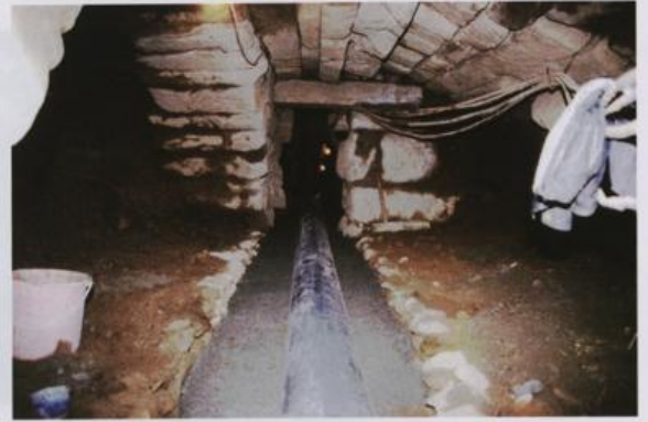
Abb. 28: Kanal unter der Kuretenstraße im Bereich der Fundamentgewölbe des Oktogons
