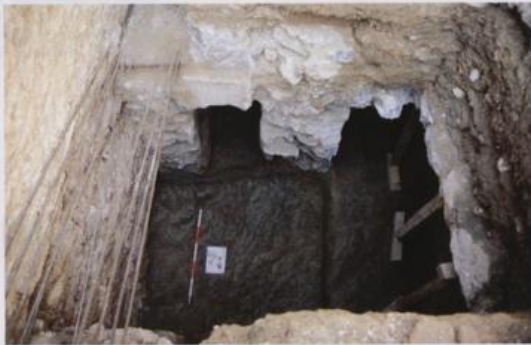
Abb. 19: Fundamentgrube in Stiegegasse 1: Links der Frischwasserkanal, der aus dem Hanghaus 1 kommt und, bevor er ins Hanghaus 2 wechselt, parallel und in Gegenrichtung zum Abwasserkanal (rechts im Bild) geführt wird
