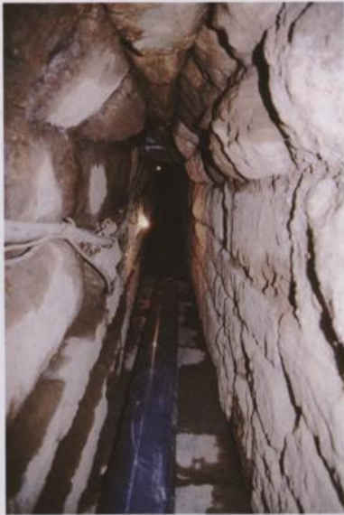
Abb. 29: Kanal unter der Kuretenstraße mit Steinplatten als Kanalsohle. Im Bild das neu verlegte Abwasserrohr, welches das Regenwasser des Hanghausdaches abführt
