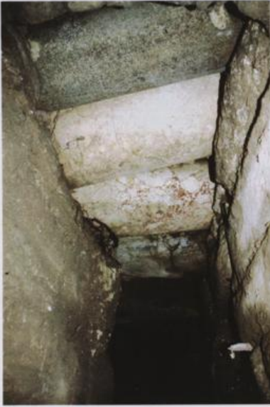
Abb. 27: Kanal unter der Kuretenstraße: Ausbesserung des Gewölbes mit Säulenschaftfragmenten
