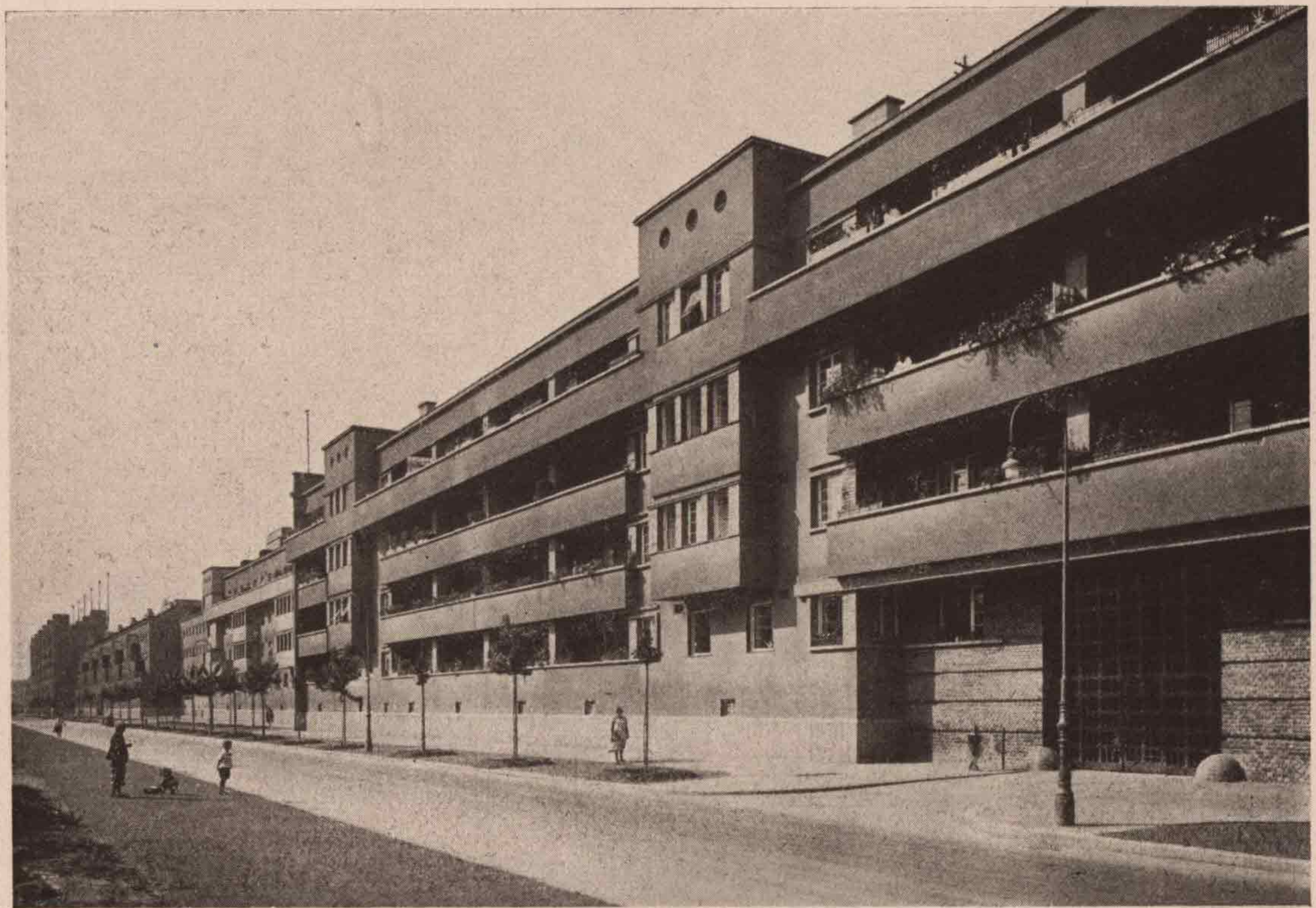
Teilansicht der Fassadenfront Boschstraße
