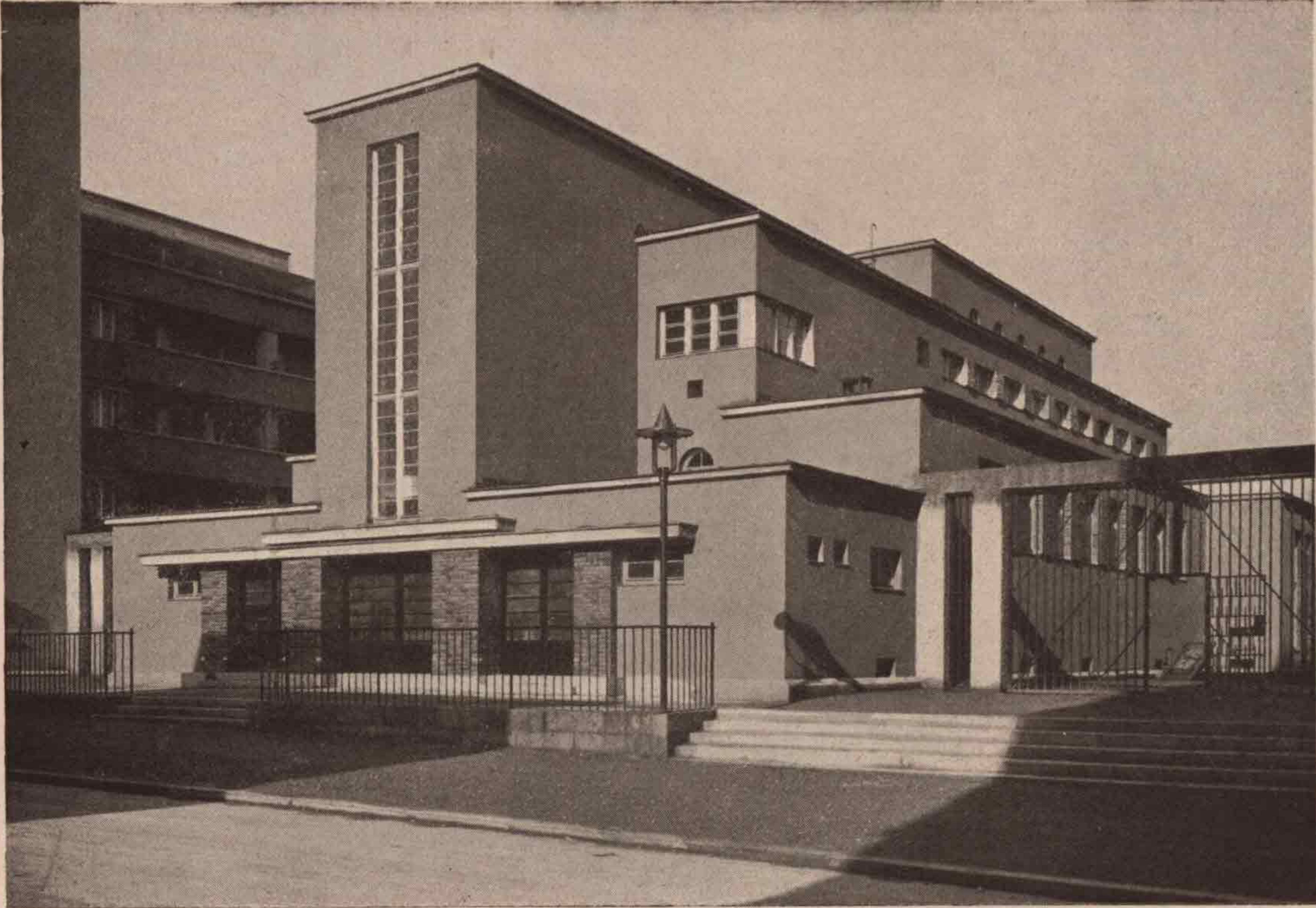
Blick auf die südlich gelegene Wäscherei
