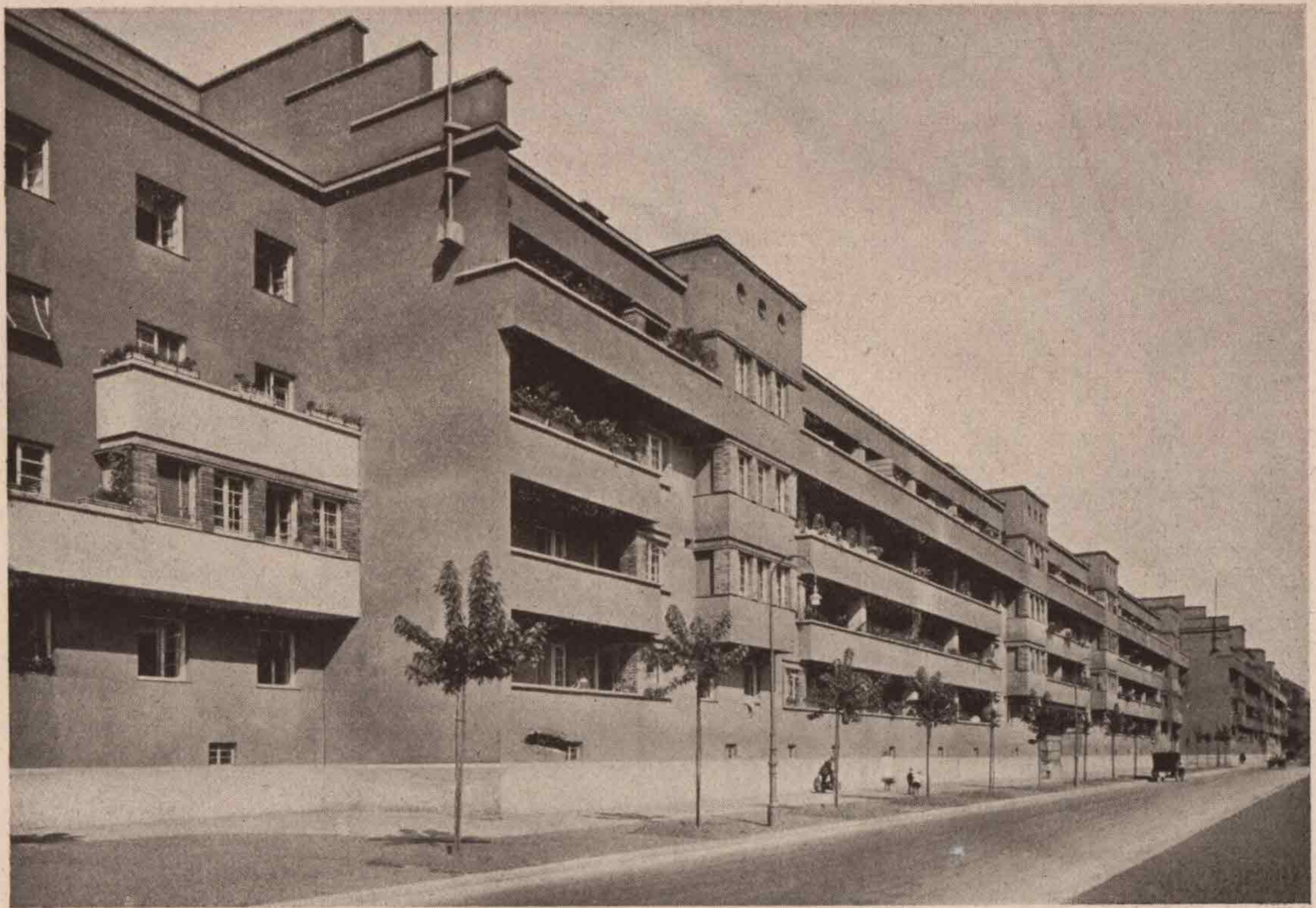
Teilansicht der Fassadenfront Boschstraße
