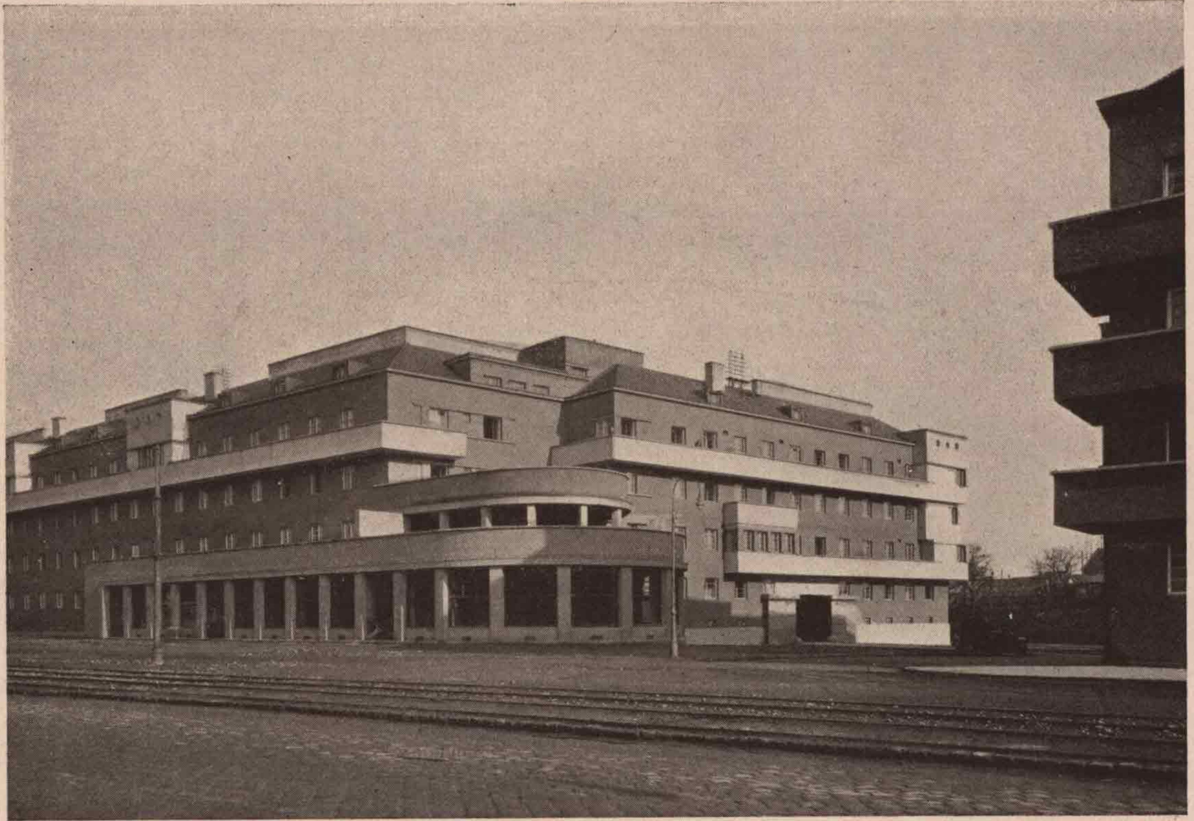
Ansicht der Front Geistinger Gasse, Ecke Heiligenstädter Straße
