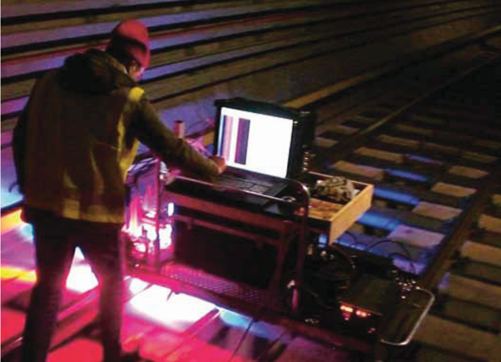
FractINSPECT – Pilotversuch mit Versuchswagen
