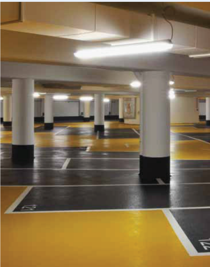
Garage Beethovenplatz nach der Modernisierung
