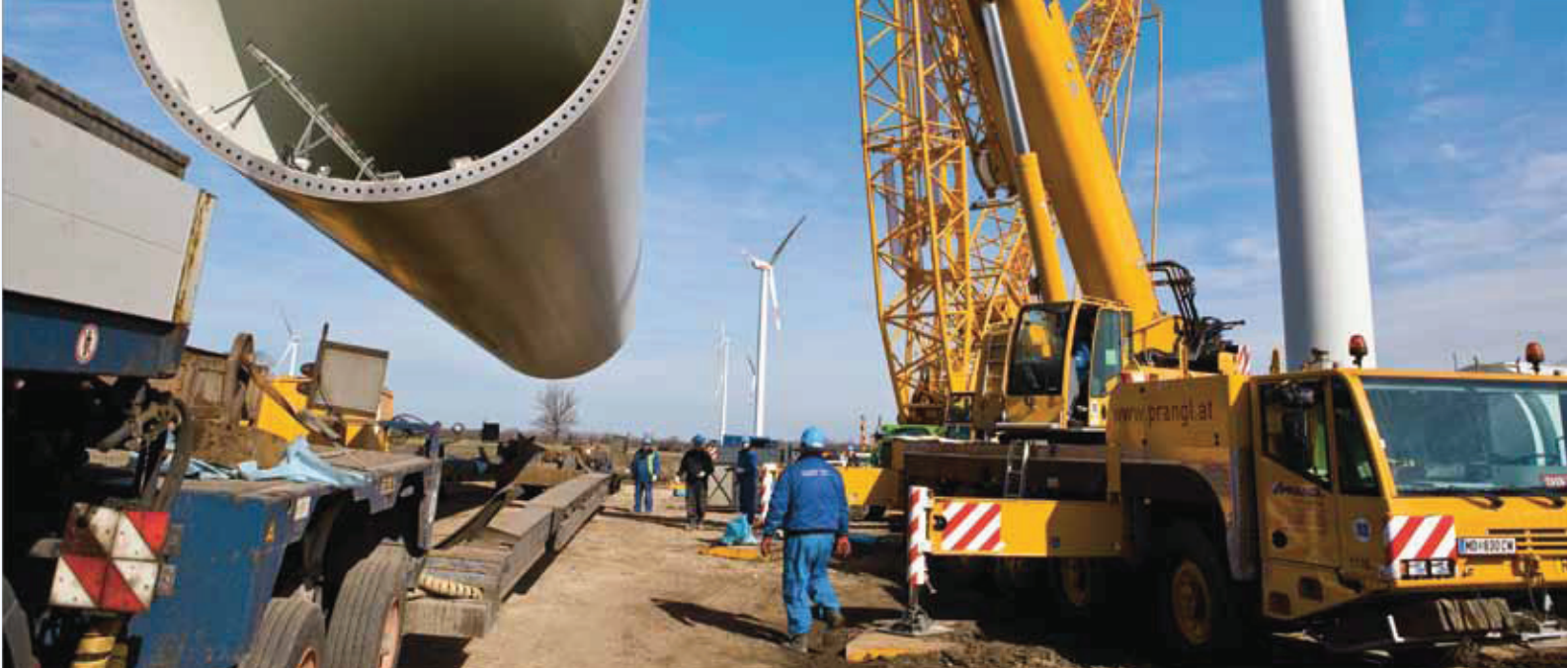
Errichtung der Windkraftanlage in Levél (1. Ausbaustufe)
