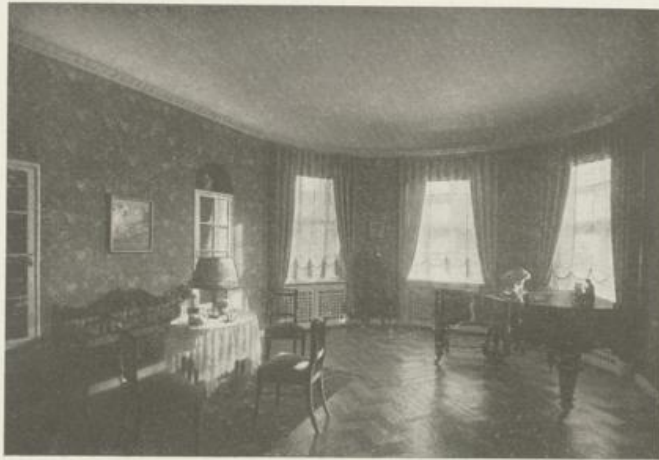
Musikzimmer Die künstliche Beleuchtung liegt verdeckt hinter dem Gesims
