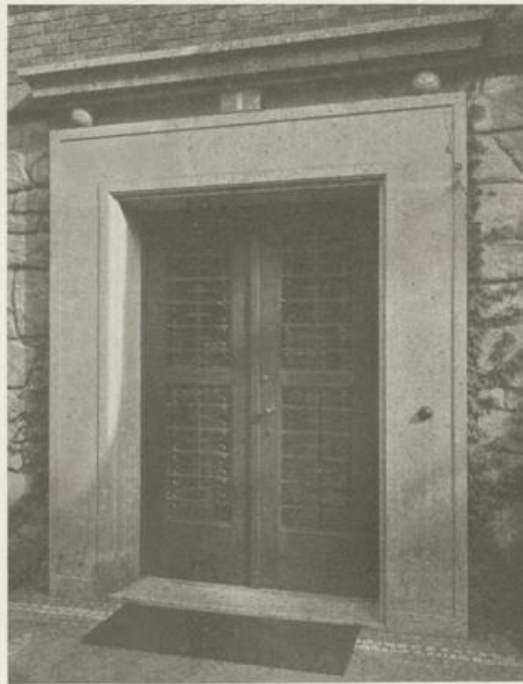
Umbau, Wien XVIII., Weimarerplatz 1, Hauseingang
