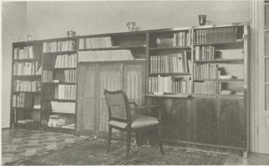
Bücherwand, verbunden mit Heizkörperverkleidung, Nußholz
