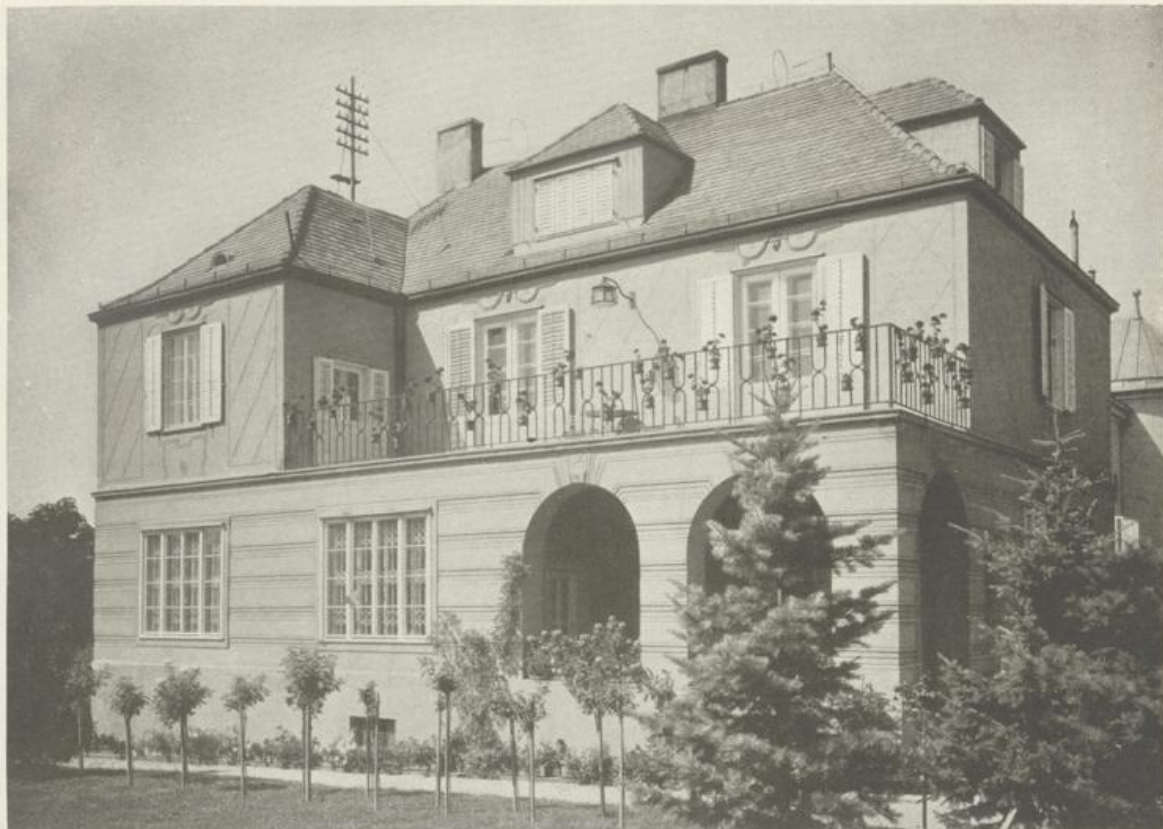
Ansicht von der Straße Die Blumentöpfe am Terrassengeländer stecken in Ringen außen an den Geländerstäben
