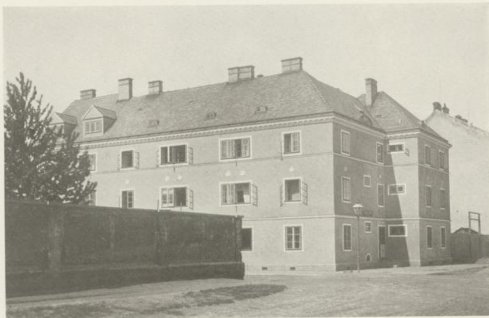
Wohnhaus für Fabriksangestellte, Wien, XXI. Bezirk, 1923
