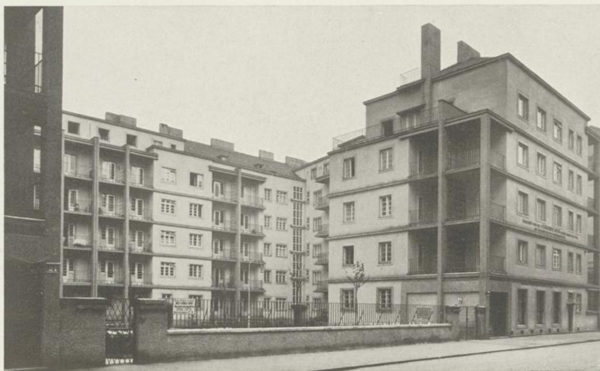
VOLKSWOHNHAUS DER GEMEINDE WIEN, III. GARTENHOF IN DER HAGENMÜLLERGASSE
