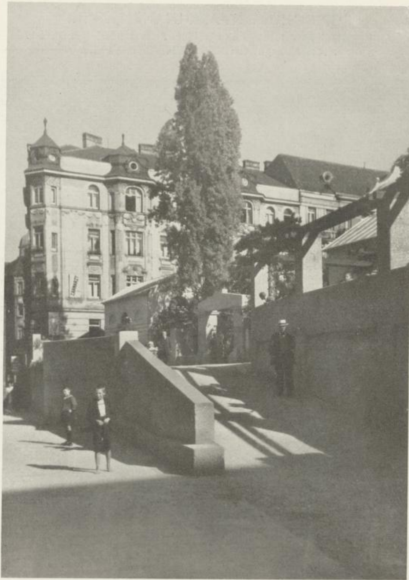
SCHUBERTPARK, AUFANG IN DER WÄHRINGERSTRASSE
