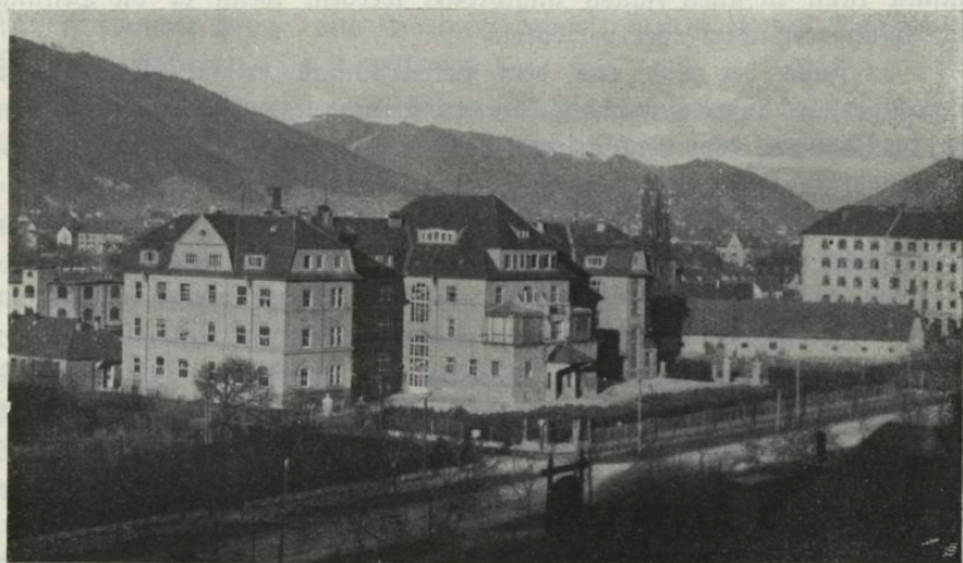
Krankenhaus der Arbeiterunfallversicherungsanstalt für Steiermark und Kärnten in Graz.
