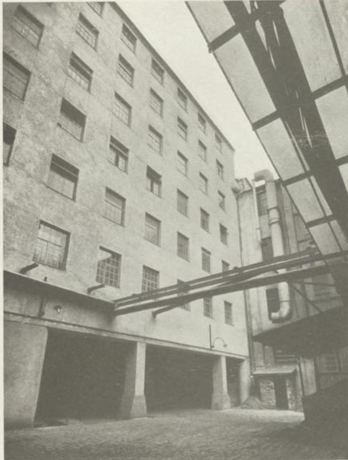
Erweiterungsbau der Fabriksanlage „Kores“, Wien, 1929
