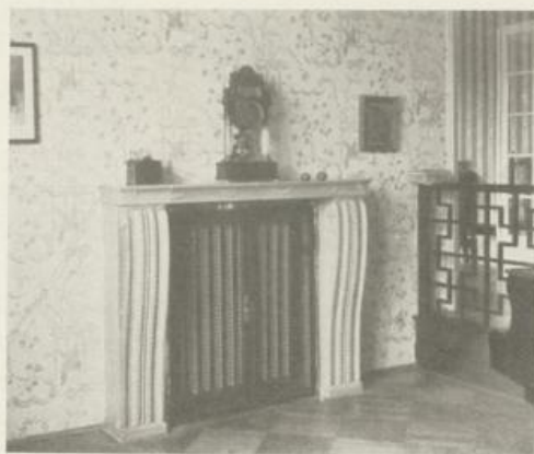
Diele Heizkörperverkleidung aus glasiertem Ton
