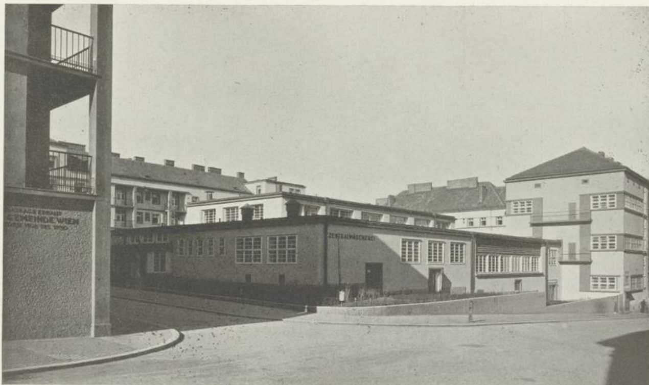
VOLKSWOHNHAUSANLAGE DER GEMEINDE WIEN, XII., AICHHOLZGASSE ZENTRALWÄSCHEREI UND BADEHAUS
