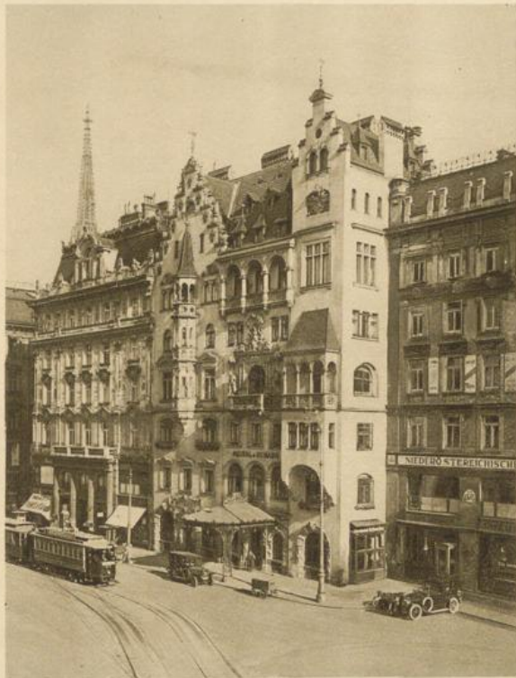
HOTEL MEISSL & SCHADN / FASSADE
