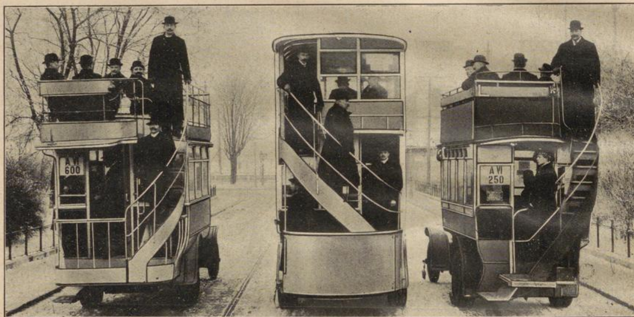
Abb. 254. Vergleichende Zusammenstellung der Auto-Omnibusse von Berlin (links), Wien (mitte) und London (rechts).
