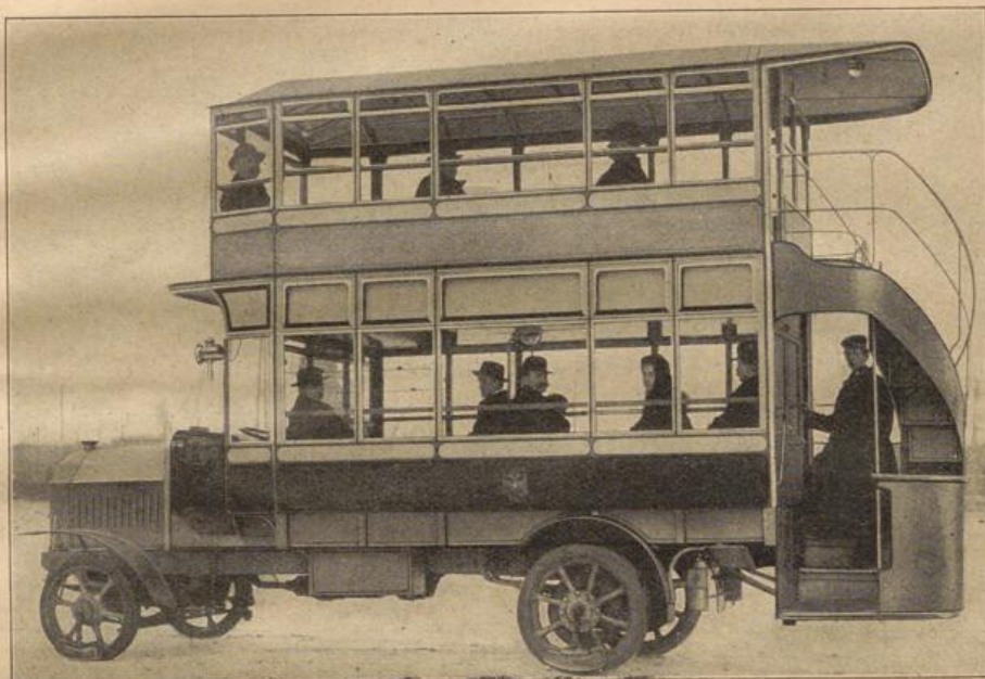
Abb. 253. Neuer Kraft-Stellwagen in Wien, Patent Spängler. (Geschlossenes Obergeschoß, Sicherheits-Stiege, Chassis der Österreichischen Vereinigung von Daimler, Fiat, Gräf u. Stift, Ventilmotor, engl. Kettengertriebe und Wurmrad-Antrieb).
