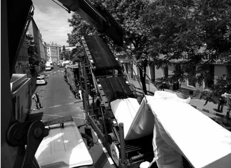
Vorrichtung zum Einfädeln des „Inliners“ auf der Kanalbaustelle Hannovergasse im 20. Bezirk. © Wien Kanal
