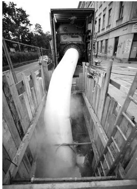
Vorrichtung zum Einfädeln des „Inliners“ auf der Kanalbaustelle am Lerchenfelder Gürtel im 7. Bezirk. © Wien Kanal
