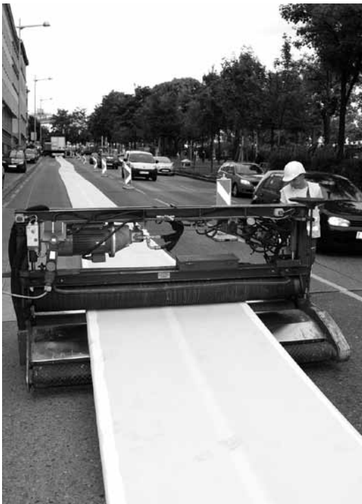
Maschinelle Vorbereitung des „Inliners“ auf der Kanalbaustelle Lerchenfelder Gürtel im 7. Bezirk. © Wien Kanal
