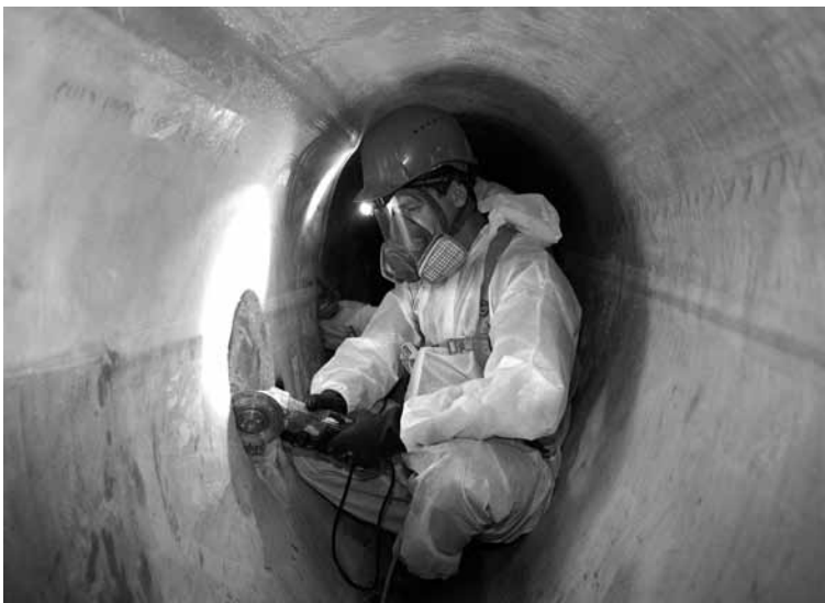
Freilegen der Hausanschlüsse an das sanierte Kanalprofil.
