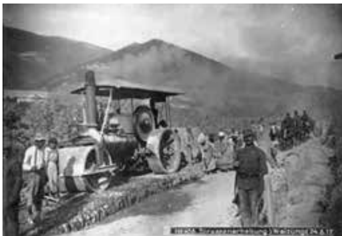
Dampfwalze beim Bau einer Versorgungsstraße, 24. August 1917 © ÖStA, KA, BS 1. WK, Isonzo 16, 2827
