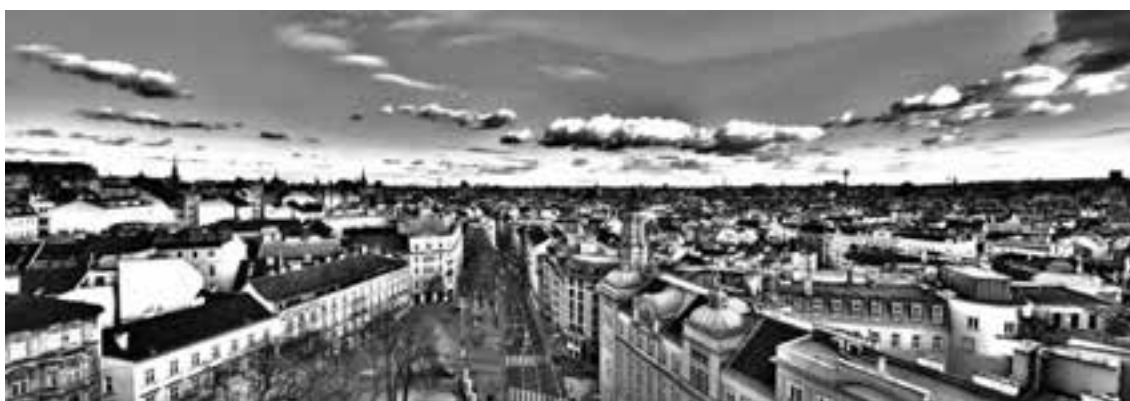
Blick von der Aussichtsplattform des „Haus des Meeres“ über die Dächer Wiens, © Steven Duchon
