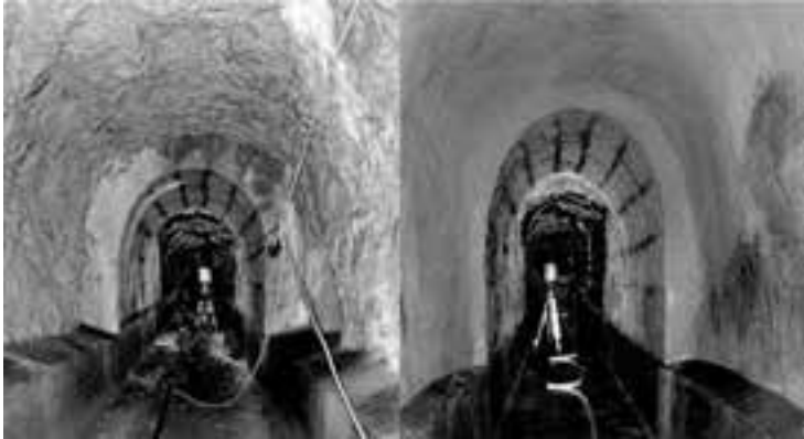
Wasserleitungsstollen vor und nach Einbringen der Spritzbetonschale
