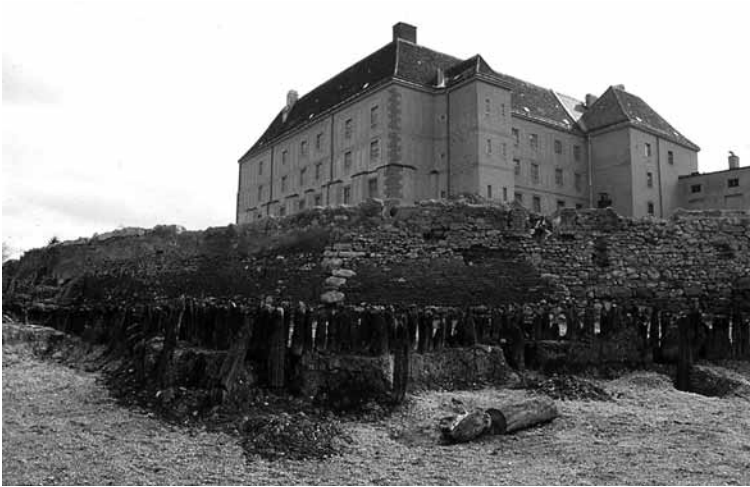
Der äußere Wassergraben des ehemaligen Schlosses Kaiserebersdorf © Stadtarchäologie Wien
