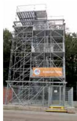
Aussichtsturm im Kompostwerk Lobau: Für die BesucherInnen im Kompostwerk Lobau, darunter viele Schulklassen, wurde auf dem Areal ein Aussichtsturm errichtet. Die rund 14 m 2 große Plattform in 12 m Höhe ermöglicht einen sehr guten Überblick auf die Anlagen und Produktionsflächen im Kompostwerk.
