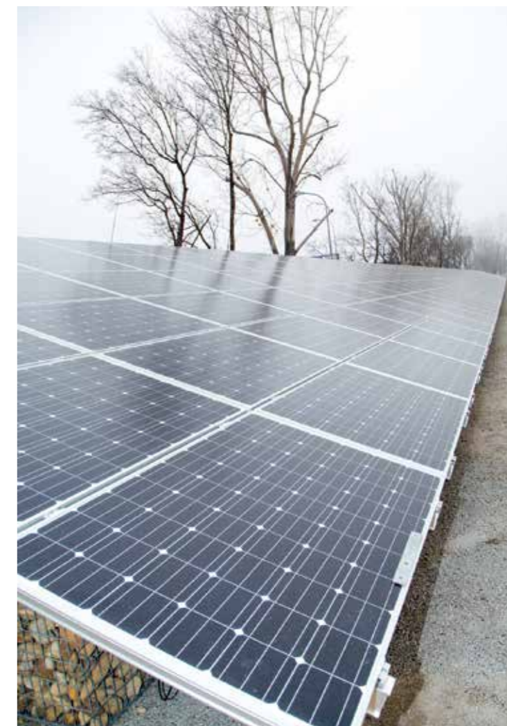
Die neue Photovoltaikanlage beim Rinterzelt hat eine Fläche von 835 m 2 und produziert 170.500 kWh Strom pro Jahr.
