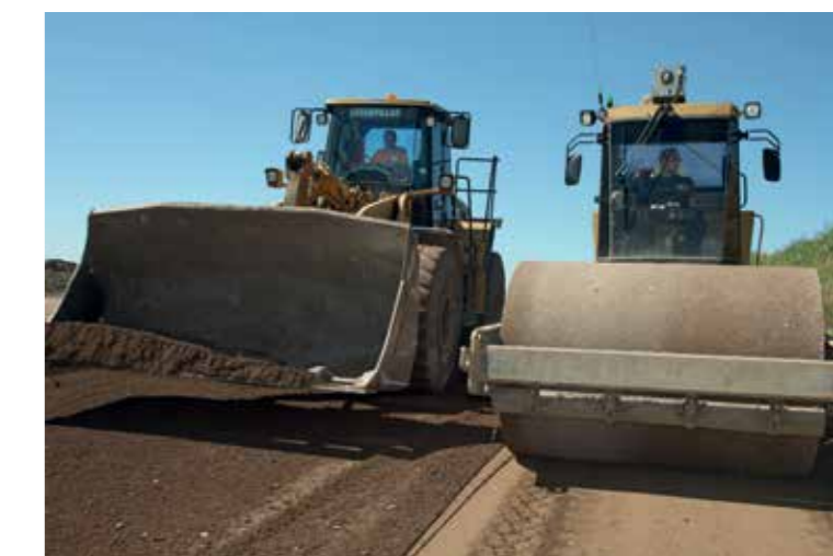
Einbau der aufbereiteten Verbrennungsrückstände auf der Deponie Rautenweg
