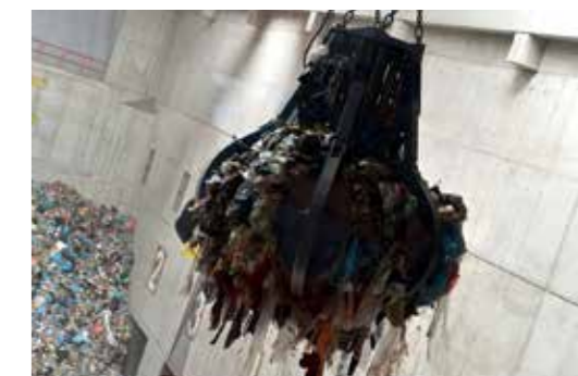
Greifer im Bunker des Abfalllogistikzentrums
