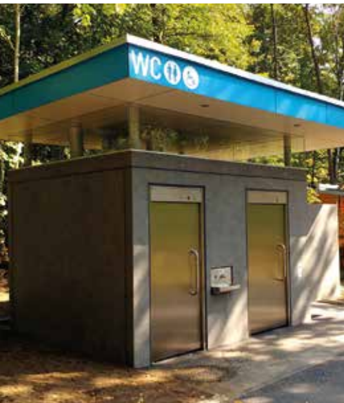
Öffentliche WC-Anlage Schwarzenbergallee
