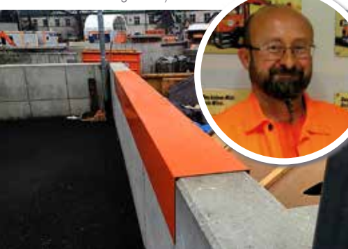
Verbesserungsvorschlag von Herbert Hirsch: Kantenschutz für Muldenmauer
