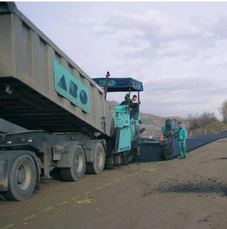
Asphaltierungsarbeiten auf der Deponie Rautenweg
