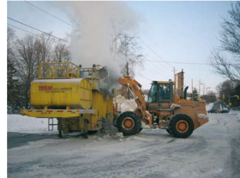
Schneesmelzanlage in Barrie, Kanada
