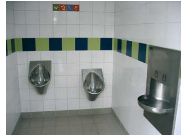
Pissoir mit wasserlosen Urinalen für Erwachsene und Kinder
