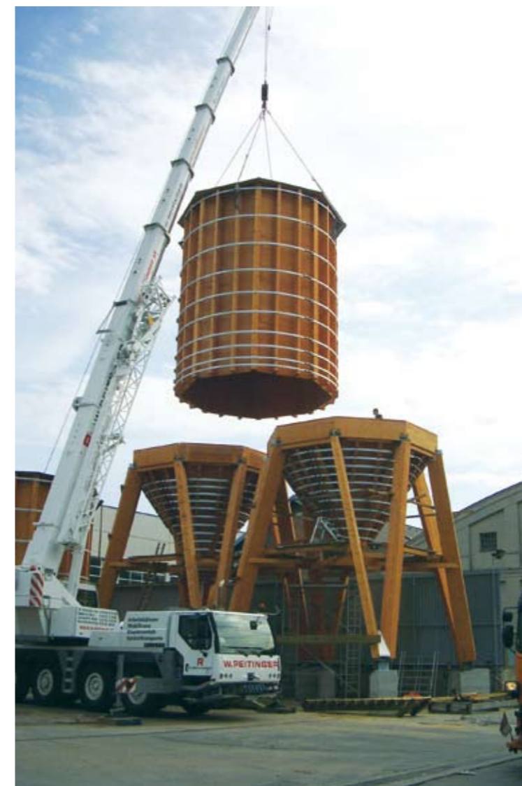
Aufstellung der neuen Holzsilos am Lagerplatz Richthausenstraße
