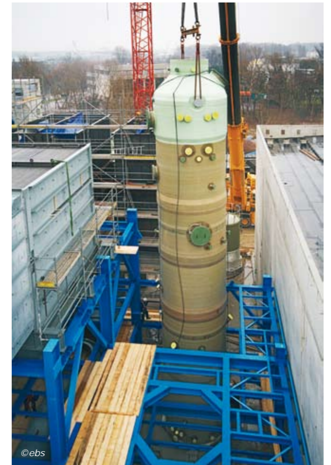
Einbau eines Wäschers - für die 2-stufige Nasswäsche
