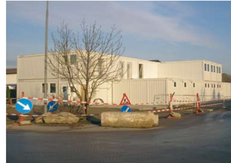
Die neue Containerunterkunft für Lenker und Müllaufleger auf dem Gelände der Deponie Rautenweg
