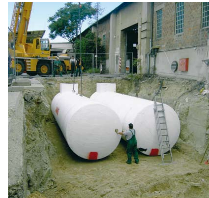
Kraftstofftank-Tausch für die Tankstelle der Garage 17
