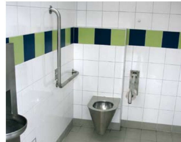
Behindertengerechte Kabine entsprechend der ÖNORM B 1600
