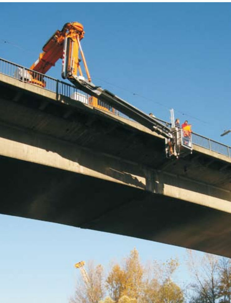
Montage der Glättewarnanlage auf der Freudenuer Hafenuerbrücke
