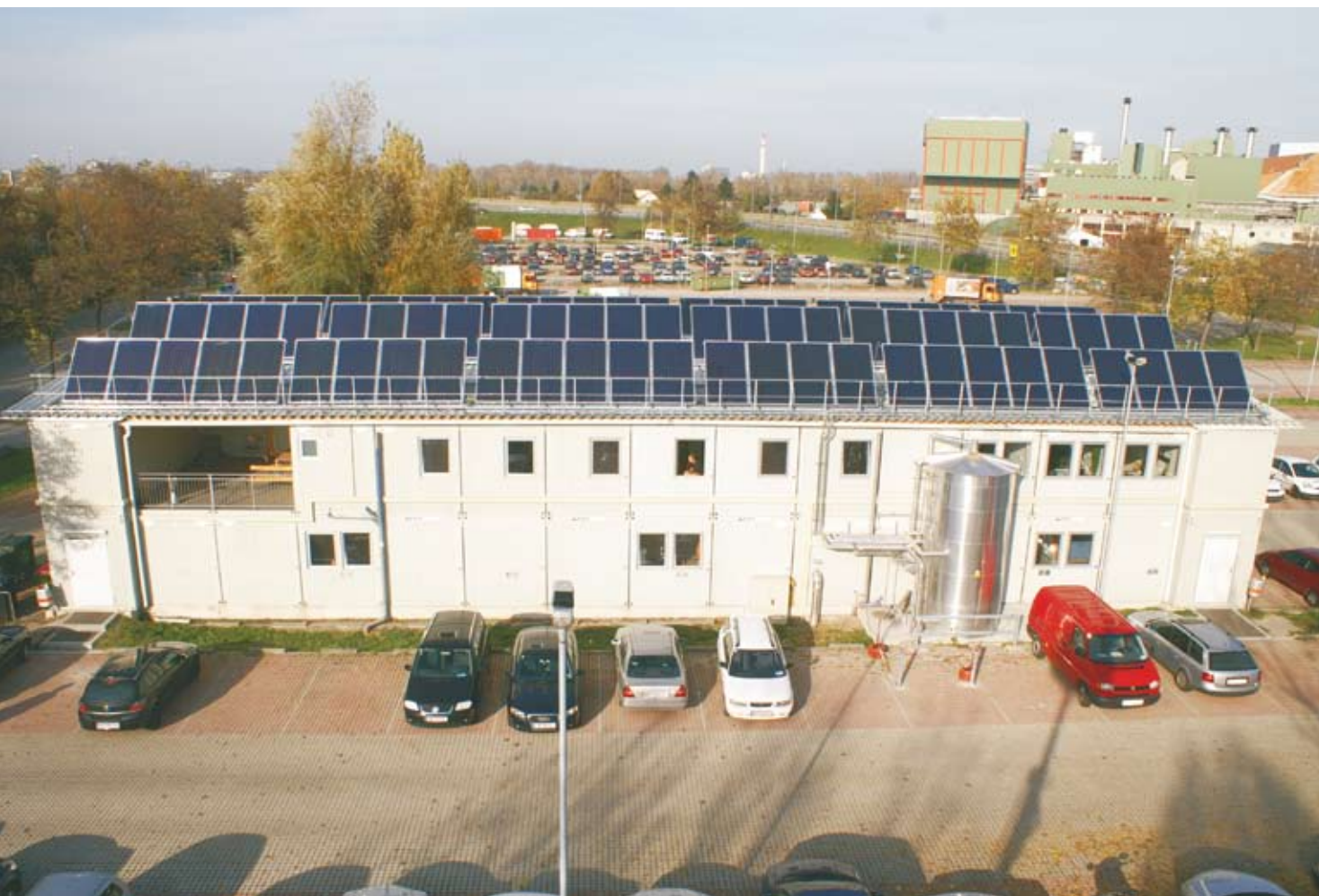
Mit der Solaranlage am Containerdorf Simmering können jährlich 56.000 kg CO 2 eingespart werden
