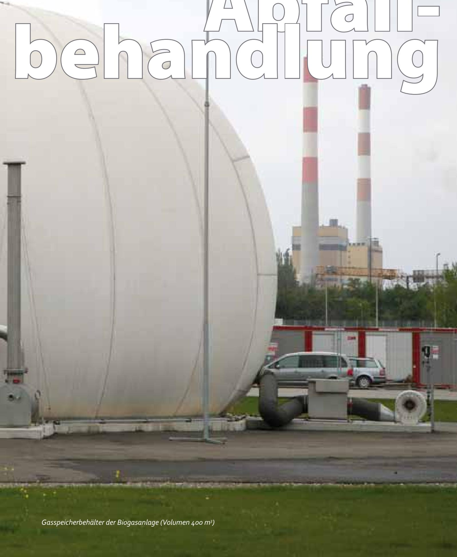
*Gasspeicherbehälter der Biogasanlage (Volumen 400 m<sup>3</sup>)*
