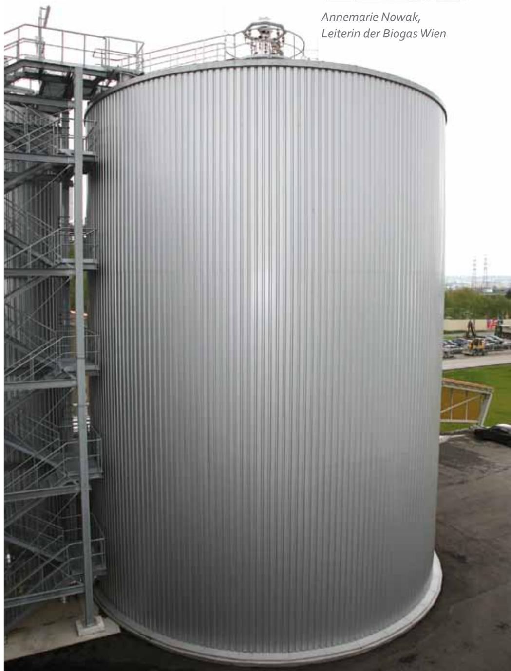
*Gärreaktor in der Biogasanlage mit einem Volumen von 2.600 m<sup>3</sup>*
