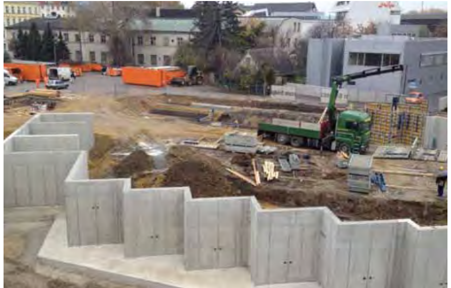
Modernisierung des Mistplatzes in Grinzing
