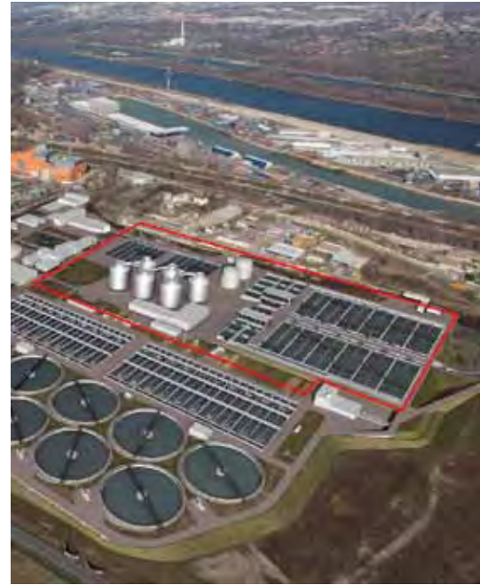
EOS: aus Klärschlamm wird Energie
