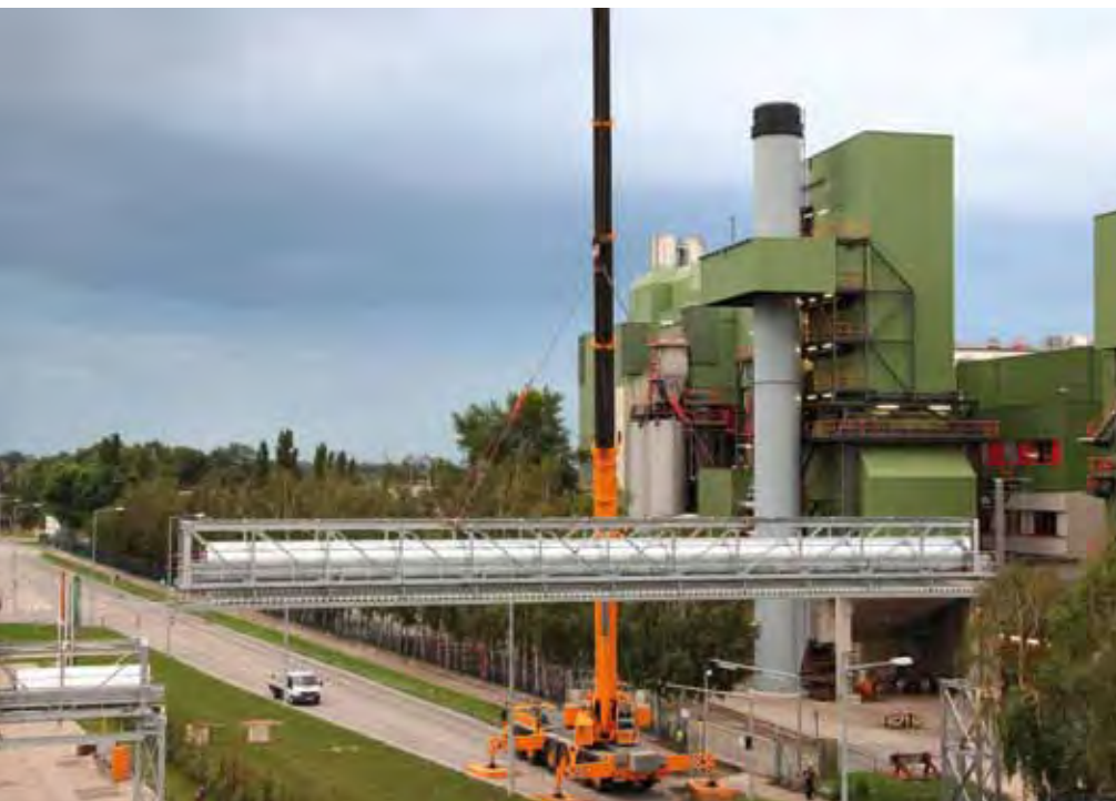
Mega-Förderband vom Abfalllogistikzentrum zum Wirbelschichtofen 4 wird eingebaut
