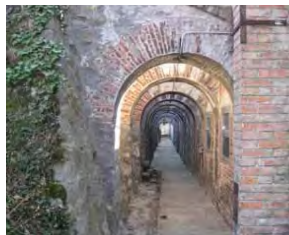
„Kalter Gang“ oberhalb der Bunkeranlage
