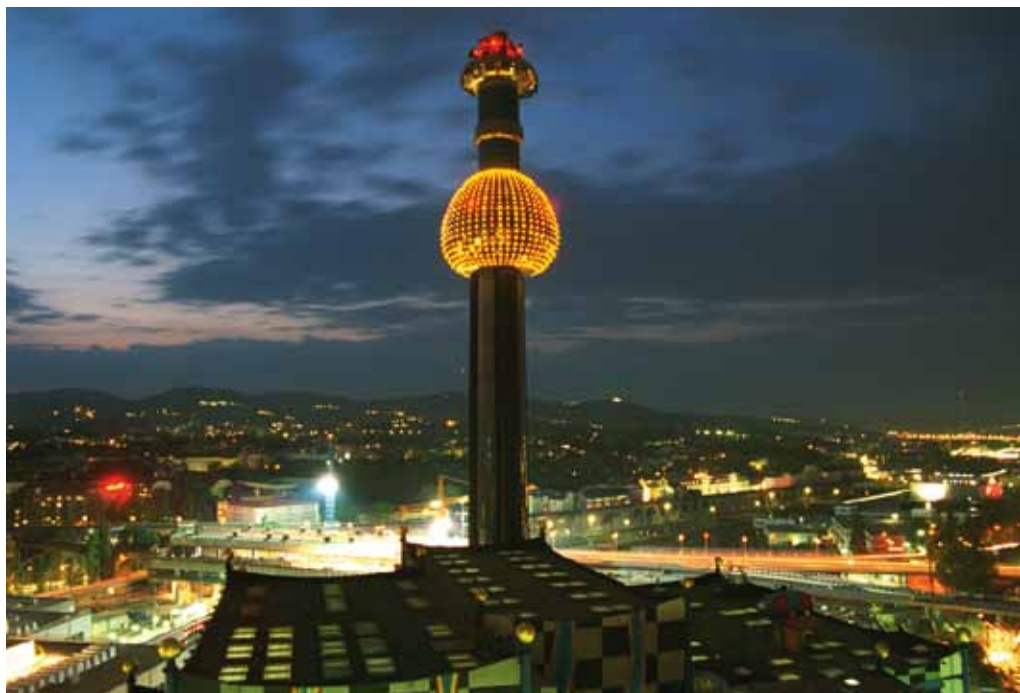
Die Müllverbrennungsanlage Spittelau wird bis 2015 generalsaniert
