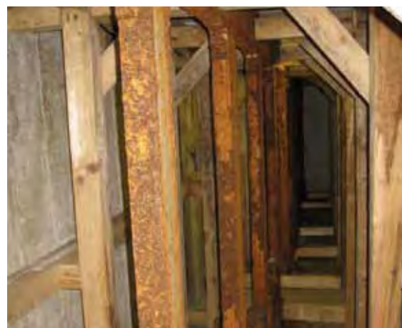
Bunkeranlage vor dem Abbruch
