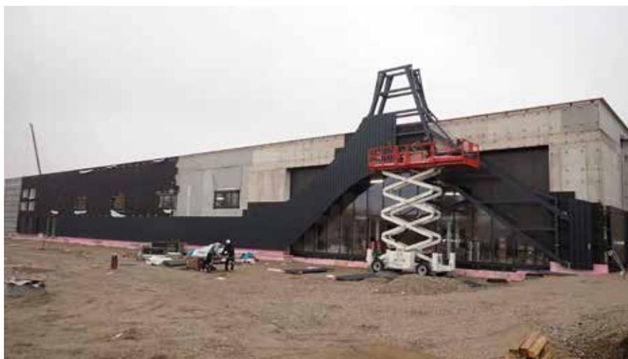
Im direkten Anschluss an das schon längst in Betrieb genommene Betriebsgebäude wurde der Bereich „Altwarenaufbereitung/Multifunktionsraum“ errichtet. Hier sind die Fassadenarbeiten in vollem Gang, es lässt sich bereits der Umriss des alten Rinterzertes erkennen, das die Fassade zieren wird.
