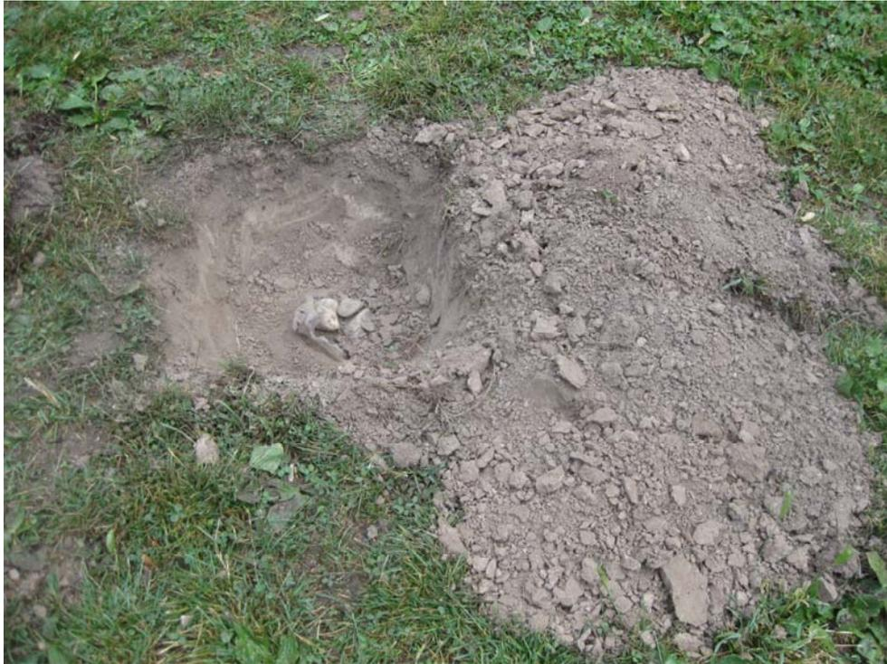
Abb 6 Aushub Messgrube A, aufgefundenes Trennvlies mit Rollierung darunter, 22.06.2015
