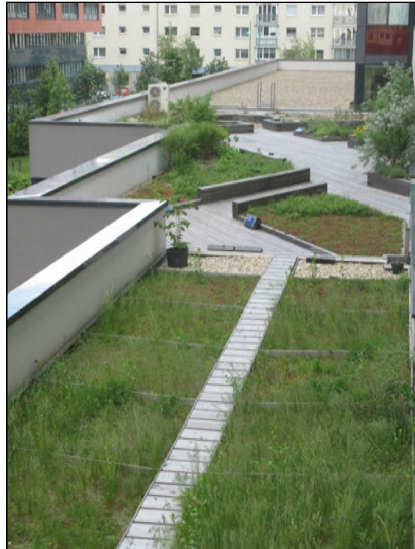
Begrünte Dachterrasse der MA22, Dresdner Straße 45
