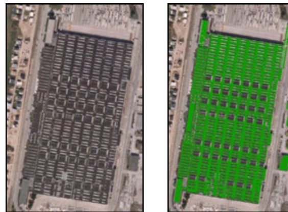
Zentralwerkstatt der Wiener Linien, Simmeringer Hauptstraße 252, A-1110 6,4 ha Dachfläche; Vogelperspektive und Erfasste Dachfläche in ArcMap
