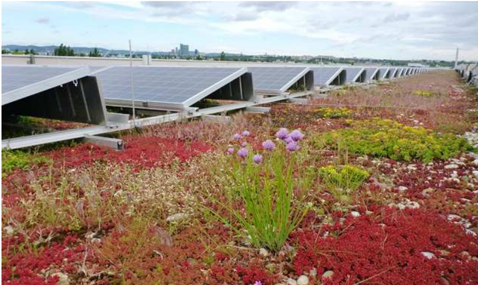
Abbildung 2 (© Pendl): Das Flachdach des Briefzentrums Wien
