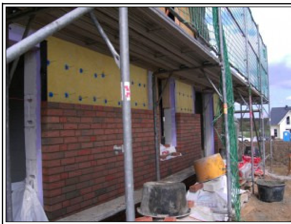
Bild 6: Wärmedämmung Fassade mit Glaswolle 1
