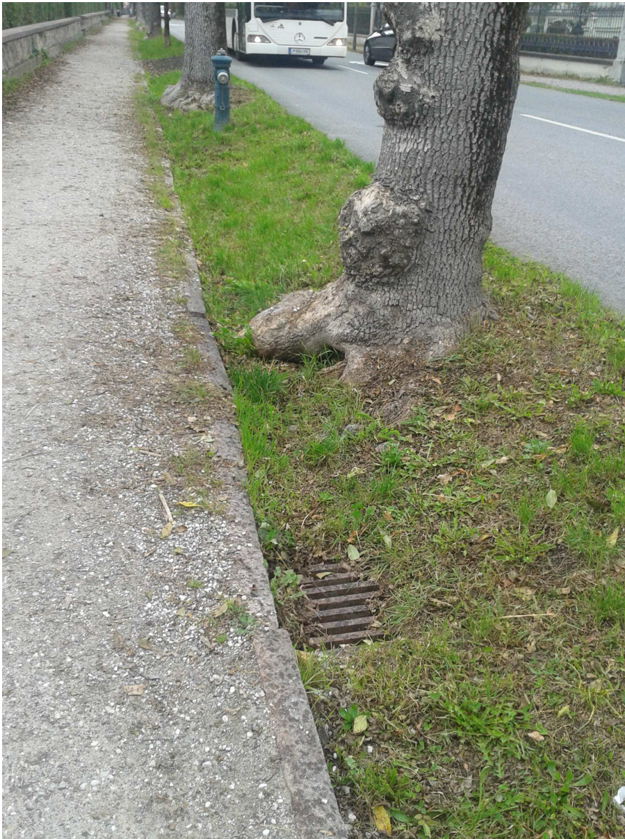
Abbildung 44: Bodenfiltermulde mit Einlaufgitter und Gehölzen [Quelle: eigene Erstellung]
