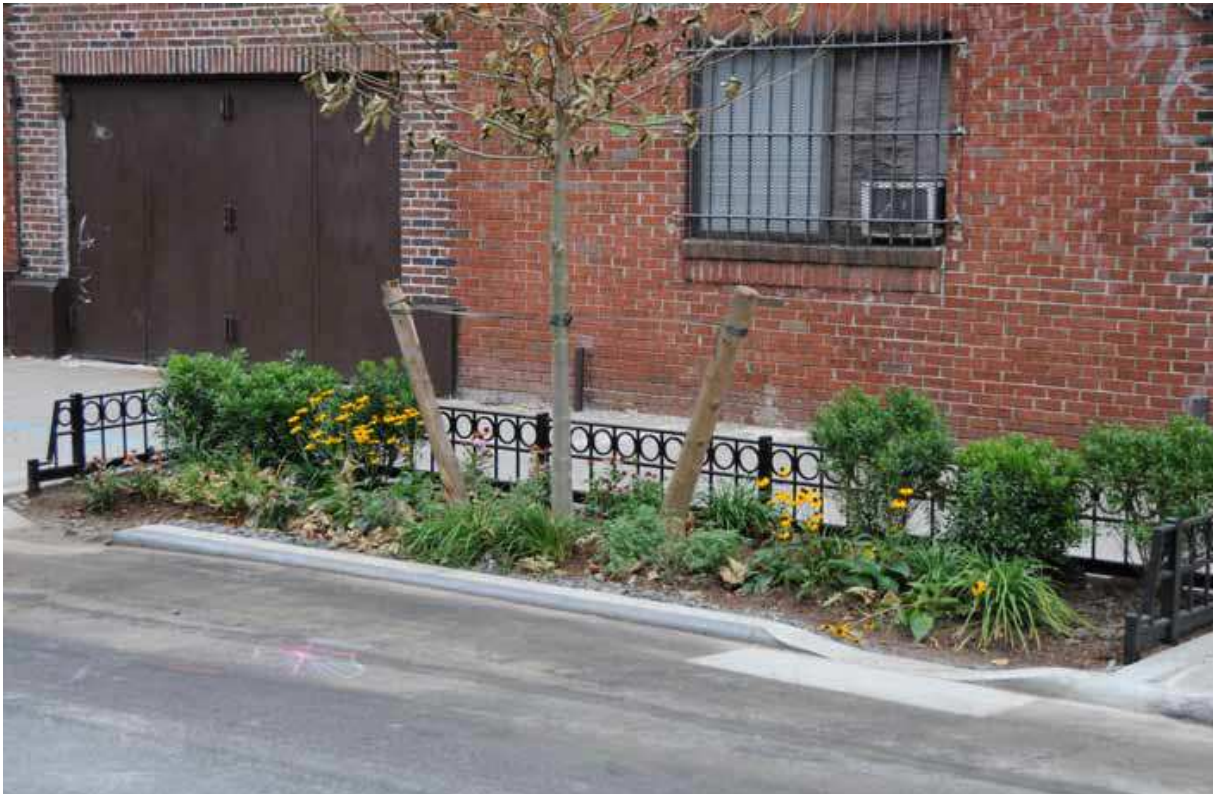
Abbildung 48: Versickerungsmulde für Straßenwasser in New York City [Quelle: NYC 2011, S. 25]
