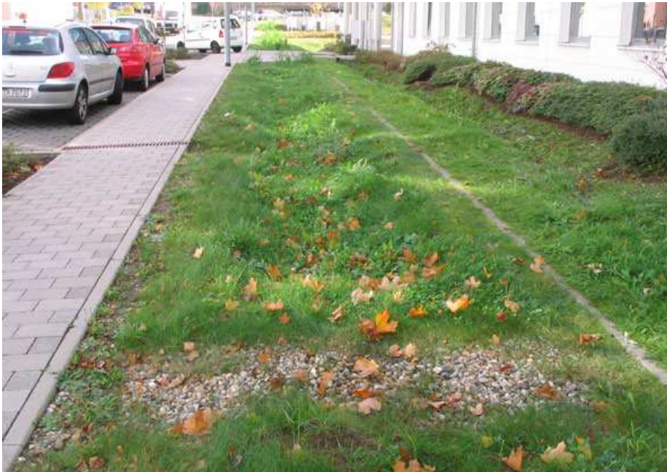
Abbildung 3: Bodenfiltermulde zur offenen Retention und Versickerung PRE-Park, Kaiserslautern [Quelle: Leitfaden zum Umgang mit Regenwasser in Siedlungsgebieten Luxemburgs, Kurzversion 2013, S. 6]
