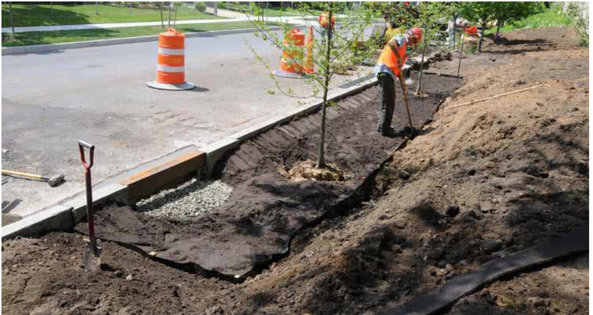
Abbildung 47: Bau einer Versickerungsmulde für Straßenwasser in Brooklyn [Quelle: NYC 2011, S. 10]
