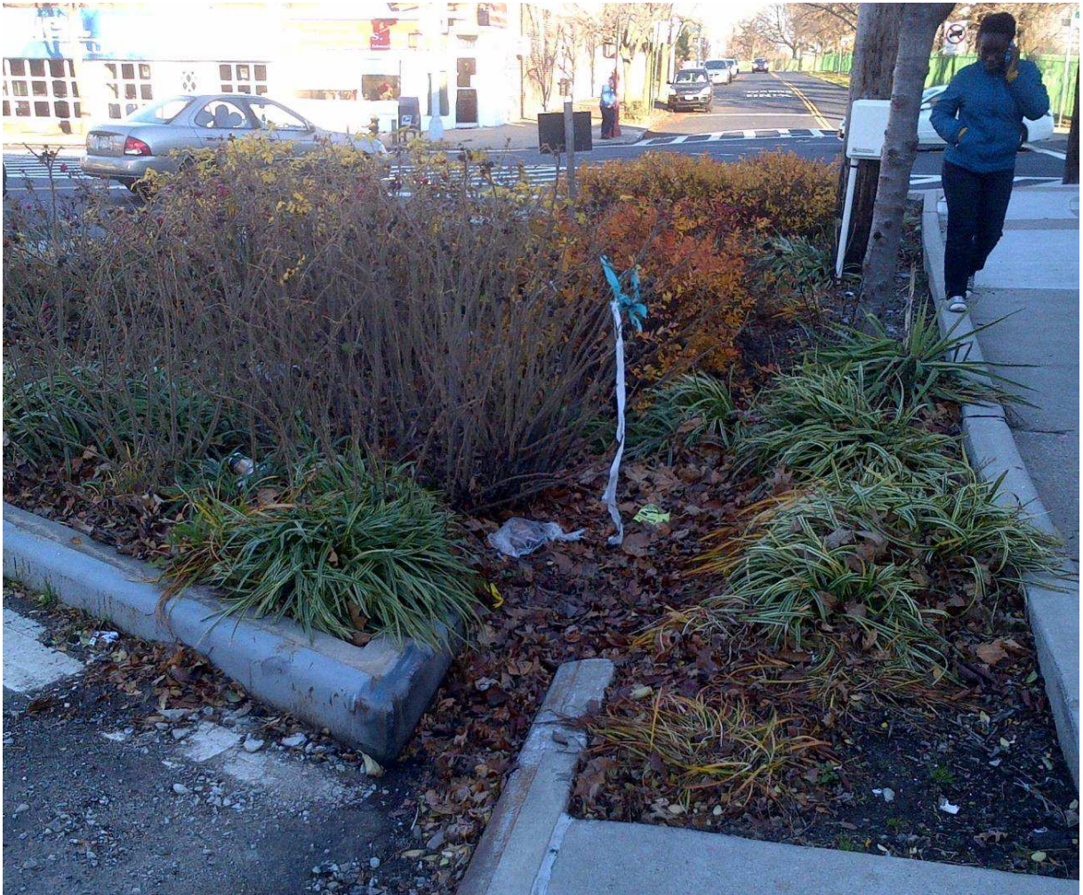
Abbildung 51: Anlage eines Regengartens gespeist mit Straßenwasser [Quelle: grow NYC o.J. ,S. 4]
