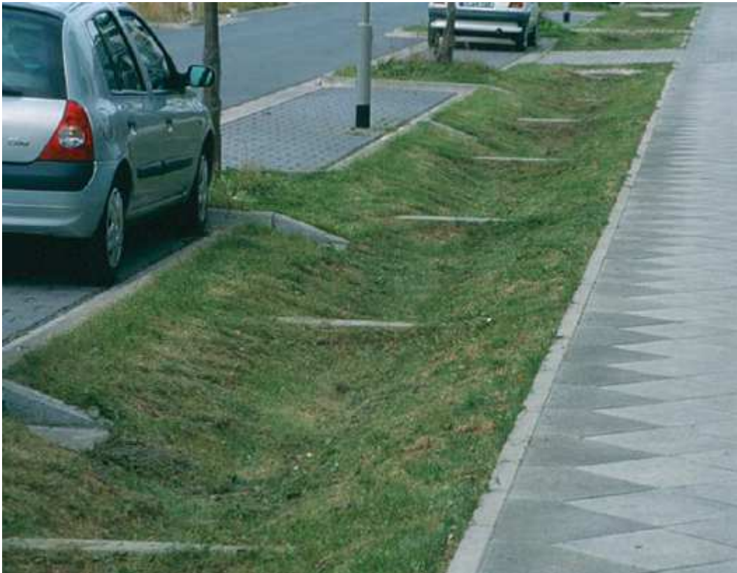
Abbildung 40: Bodenfiltermulde mit Retentionsfunktion [Quelle: Bayerisches Landesamt f. Wasserwirtschaft, 2005,S. 23]
