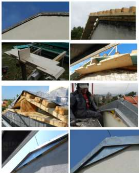
Abbildung: Nischenbildung. a) Situation vor Dämmung b) Dachverlängerung. c) Vorbereitung Baubrett für Doppelnische auf Bausteine mit direkt vom Bau genommenen Maßen. d/e) Montage Baubrett. f) Hochziehen Dämmung bis unter Holzkonstruktion und Dachabdeckung. g) Verbleichung nach Spachtelung. h) Verputzen / Einfärben der Wärmedämmung
