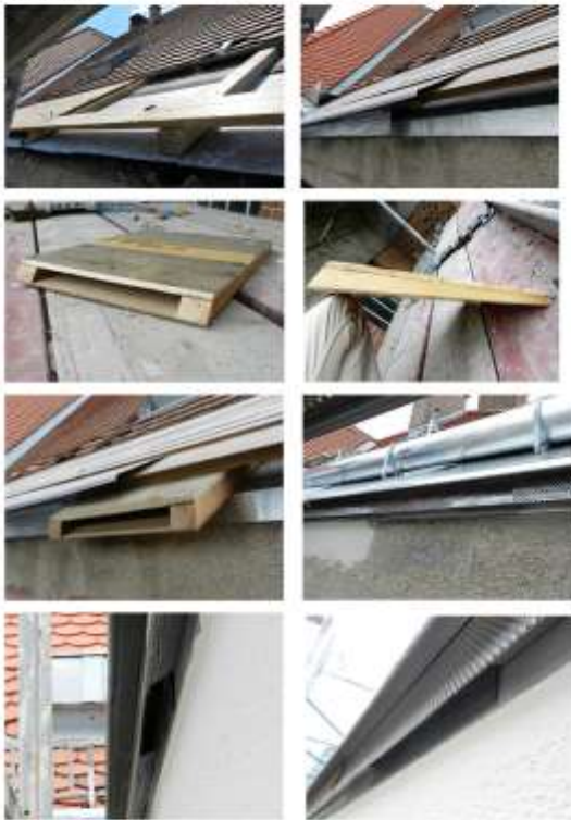
Abbildung: Montage in Zwischendach: a) Schrägung b) Beginn Verblechung c)/d) Fledermausquartier e)/f) teilweises bzw. vollständiges Einschieben des Fledermausquartiers, e) Öffnung in Verblechung von unten, f) gespanntes Gummiband als Kletter- und Kriechhilfe, um Eingang zu erreichen.
