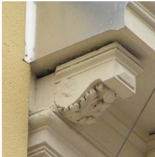
Abb. 9: Zierkonsole mit einem Abstand von etwa 2-3 Zentimeter zur Untersicht des Gesimses. Beispiel Hartmannspital
