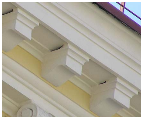
Abb. 10 Zierkonsolen mit stirnseitigem Anschluss an das Gesimse. Beispiel Argentinierstraße
