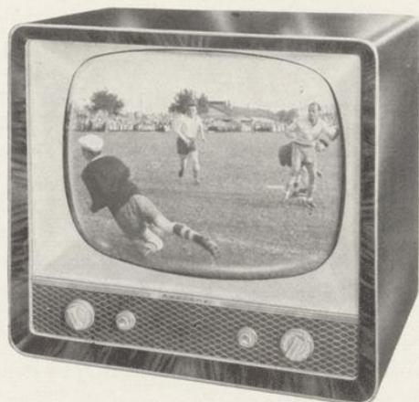
Der technische Aufbau dieses Gerätes ist der gleiche wie bei der Type 853. Verwendet wird jedoch die 43-cm-Weitwinkel-Bildröhre mit der etwas kleineren Bildfläche. Auch dieses Gerät ist in einem vornehmen, geschmackvollen Edelholzgehäuse untergebracht und sonst mit allen Vorzügen des zuerst beschriebenen Gerätes ausgestattet, mit Ausnahme des Schlüsselschalters und der 3-D-Ausführung.
