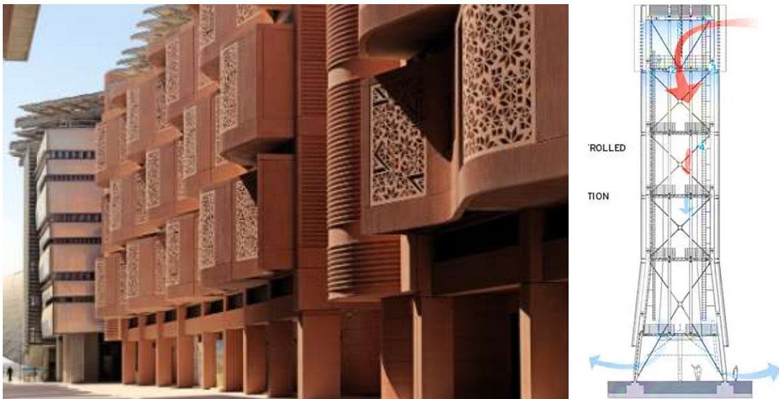
Abbildung 7: Traditionelle Verschattungselemente am Masdar Institute of Science and Technology © Barlow, 2017 (links), Funktionsprinzip des arabischen Windturms in Masdar City © Masdar City, 2019
