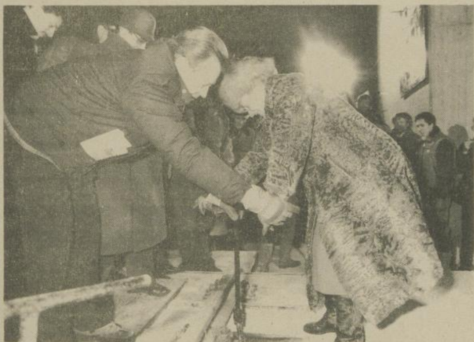
Der letzte Nagel ist eingeschlagen! „Tunnelpatin“ Familienminister Gertrude Fröhlich-Sandner und Verkehrsstadtrat Johann Hatzl schlossen mit dem Einschlag des letzten Nagels die Schienenlegung des ersten Abschnittes der U 6 unter der Pottendorfer Straße ab.
