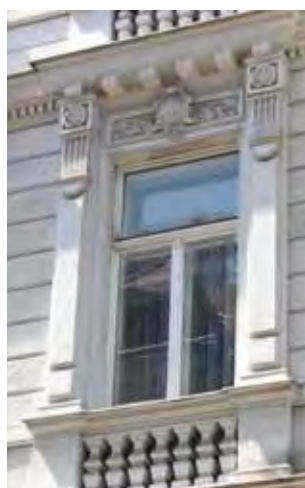
Abb. 20, 21, 22: Varianten von Kastenfenstern hinter einem Gewände
