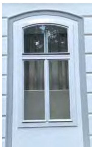
Abb. 28, 29, 30: Fassadenbündige Kastenfenster mit nach innen aufgehenden Fenstern
