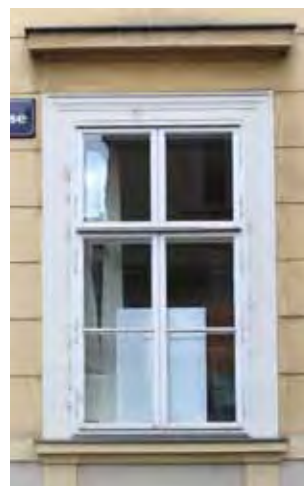
Abb. 24, 25, 26: Fassadenbündige Kastenfenster, Öffnungsrichtung außen/innen
