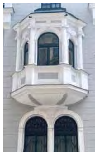
Abb. 32, 33, 34: Rundbogenfenster fassadenbündig oder hinter einem Gewände
