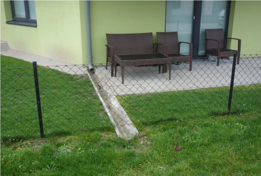
Foto 16 Dachableitung in außenliegenden Fallrohren und Betonhalbschalen durch Eigengarten zur Versickerungsmulde
