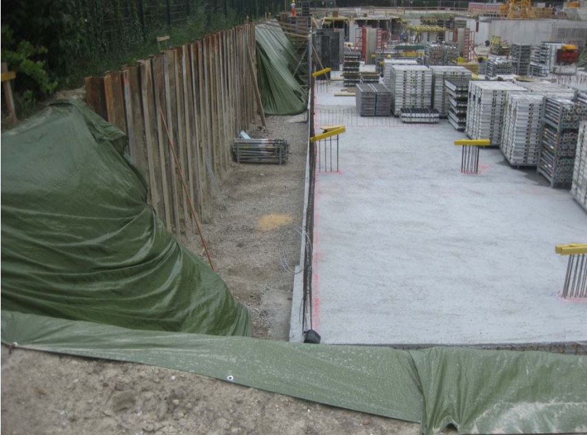
Foto 7 Bereich des nördlichen Lichtatriums an der Sohle durchlässige Kiessande
