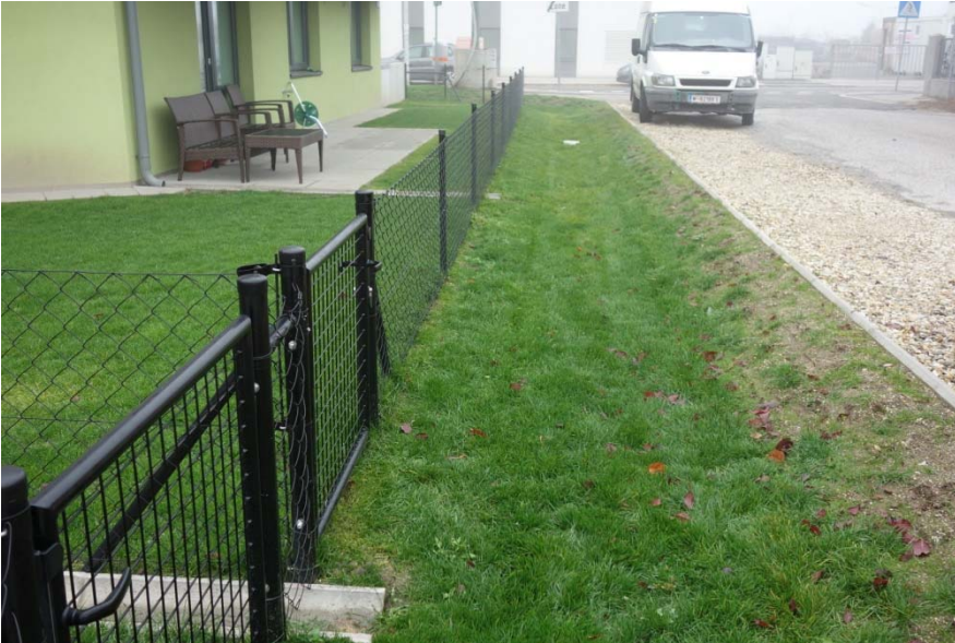
Foto 24 Sickermulden (Mulden-Rigol-Elemente) an der Außengrenze der Bauparzelle zum öffentlichen Gut, Zuleitung in Betonhalbschalen durch die Eigengärten
