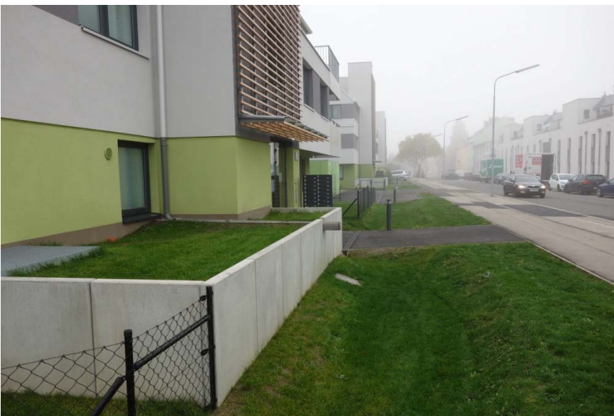
Foto 19 Sickermulden (Mulden-Rigol-Elemente) an der Außengrenze der Bauparzelle zum öffentlichen Gut
