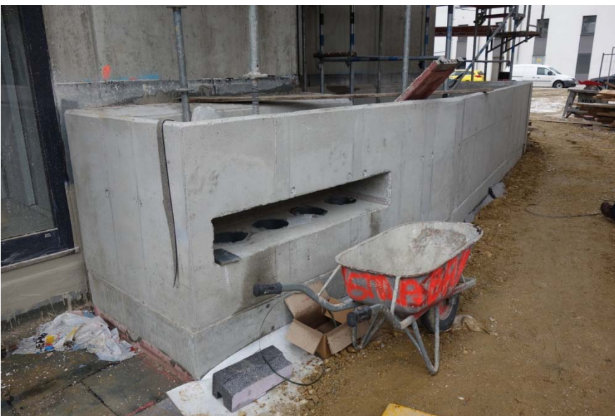
Foto 10 Retentionsraum „Sumpfbeet“: Betontrog zum Wasserrückhalt verbunden mit Leitungsschacht im Vordergrund
