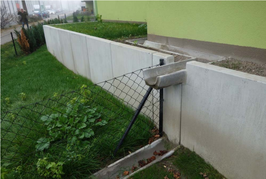
Foto 18 Ableitung in Betonhalbschalen im Hochbeet mit Gefällsstufe zur Nullebene
