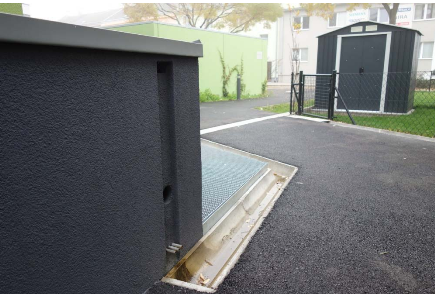
Foto 21 Notüberlauf und gedrosselter Ablauf aus dem Retentionsraum „Sumpfbeet“
