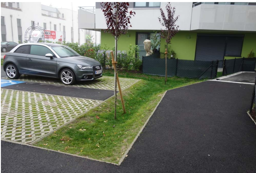
Foto 23 Versickerungsfähige Behindertenparkplätze mit Rasenmuldensteinen, Versickerungsmulde mit Baumpflanzung
