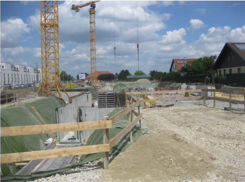
Foto 5 Blick nach N in Richtung Anfänggasse Bodenplatte und Kellerwände in Bau
