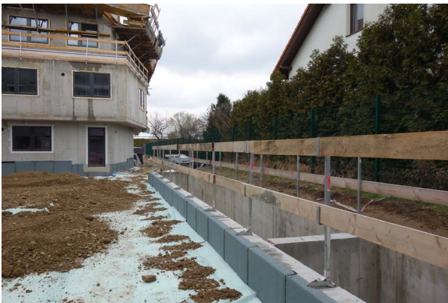
Foto 14 Dachabdichtung über dem Kellergeschoß, Tiefbeet im Lichtatrium
