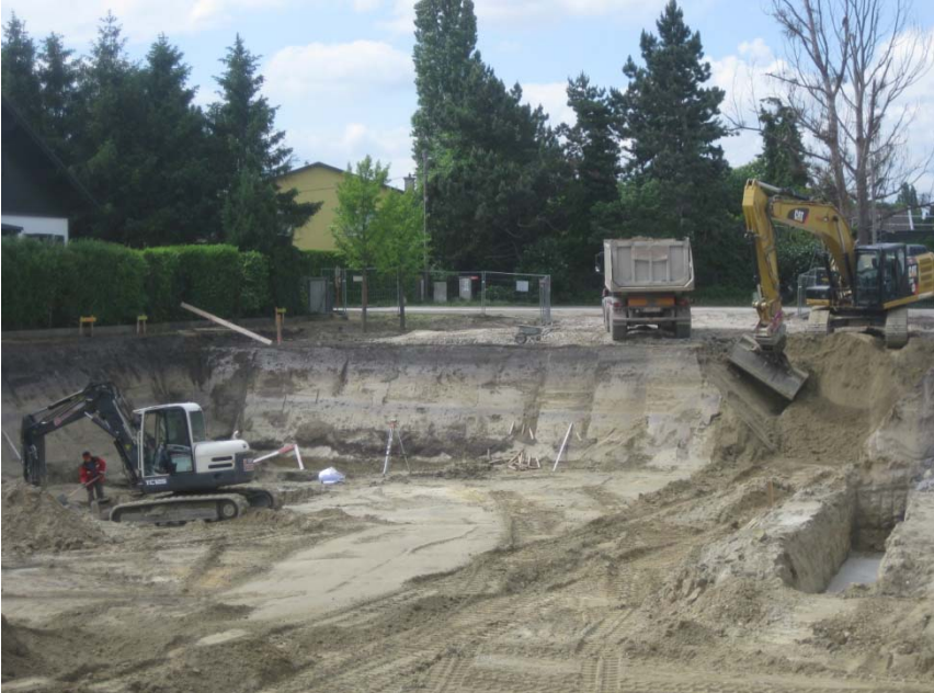
Foto 3 Baugrube: Blick nach S in Richtung Fundergasse relativ dichte Feinsande und Schluffe an der Baugrubensohle
