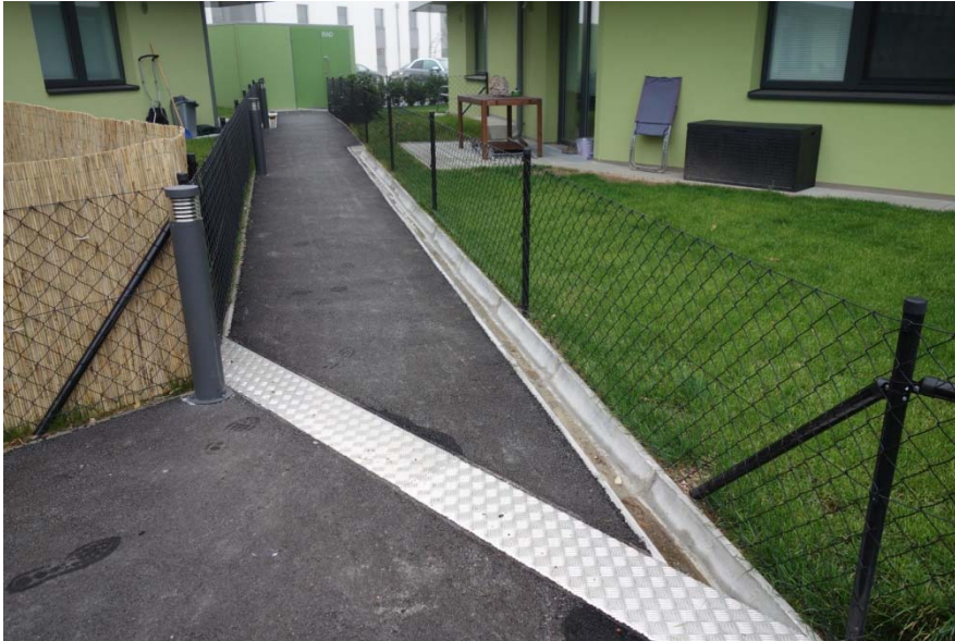
Foto 22 Abfluss in offenen Rinnen entlang von Wegen, Wegequerung mit Riffelbleckabdeckung
