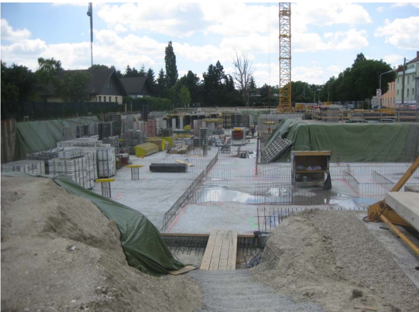
Foto 6 Blick nach S in Richtung Fundergasse Bereiche der zukünftigen Lichtatrien links im Bild bei den Spundwänden
