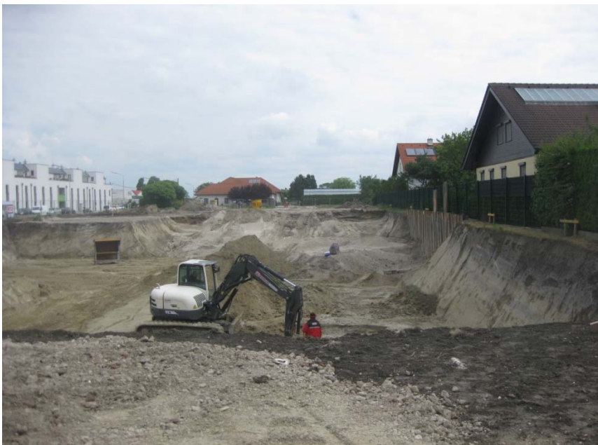
Foto 2 Baugrube: Blick nach N in Richtung Anfanggasse
