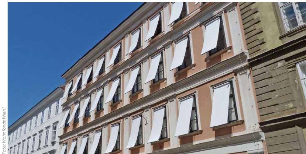
Abb. 44 Außenliegender Sonnenschutz im Denkmalschutz
