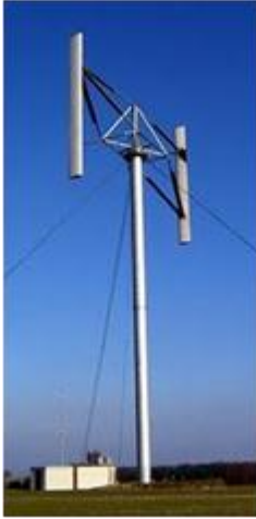
Abbildung 3-7 H-Darrieus Rotor
