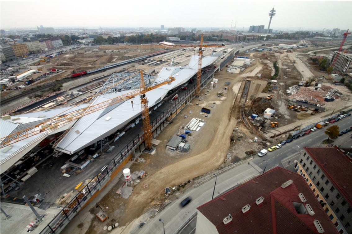
*Beim Stationsgebäude ist der Aufbau der zweiten Reihe des Rautendachs bereits weit fortgeschritten. Die schwarzen Rahmenelemente an der äußeren Gebäudekante dienen zukünftig der Aufnahme von Schallschutzpaneelen.*
