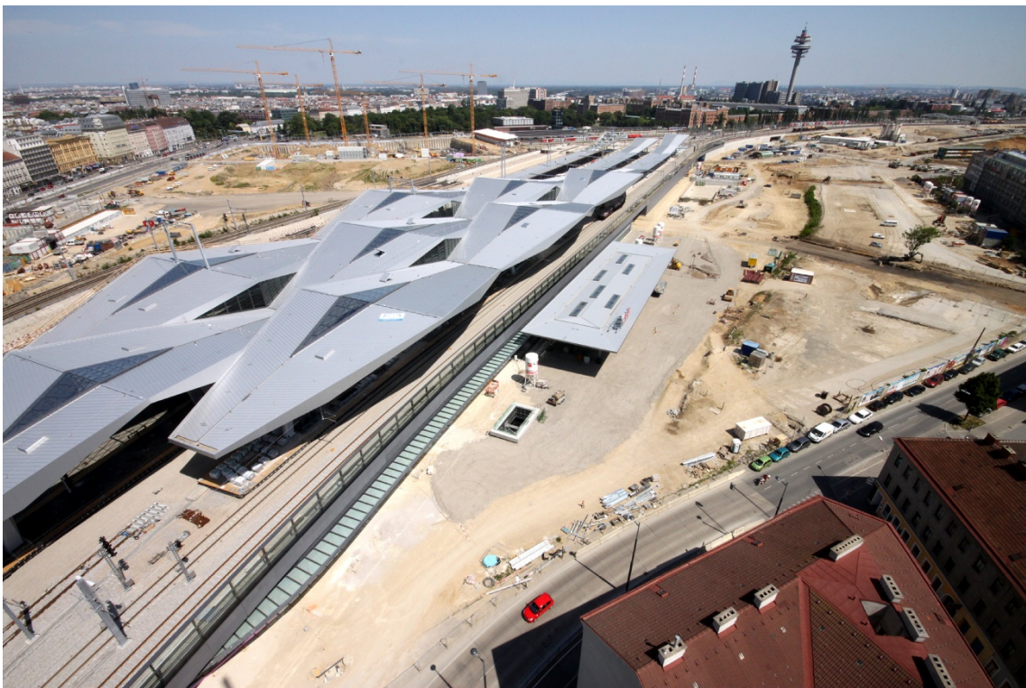
Der dritte Bahnsteig des Hauptbahnhofs Wien ist bereits überdacht, das große Vordach am Vorplatz Süd fertig. Ab sofort wird an der Ausgestaltung des Vorplatzes selbst gearbeitet. Die Kräne im Hintergrund kennzeichnen die Lage des Erste Campus
