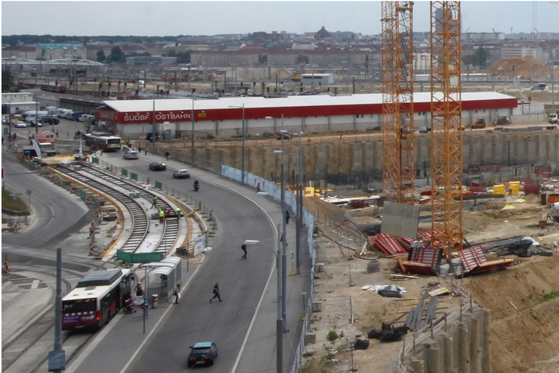
In der Arsenalstraße werden von den Wiener Linien bereits die Gleise für die verlängerte Streckenführung der Straßenbahnlinie D Richtung Südbahnhof-Ostbahn und weiter zum östlichen Ausgang des Hauptbahnhofs Wien verlegt. Links ist die Abzweigung in die Umkehrschleife im Schweizergarten zu sehen, rechts die Baugrube der Erste Group
