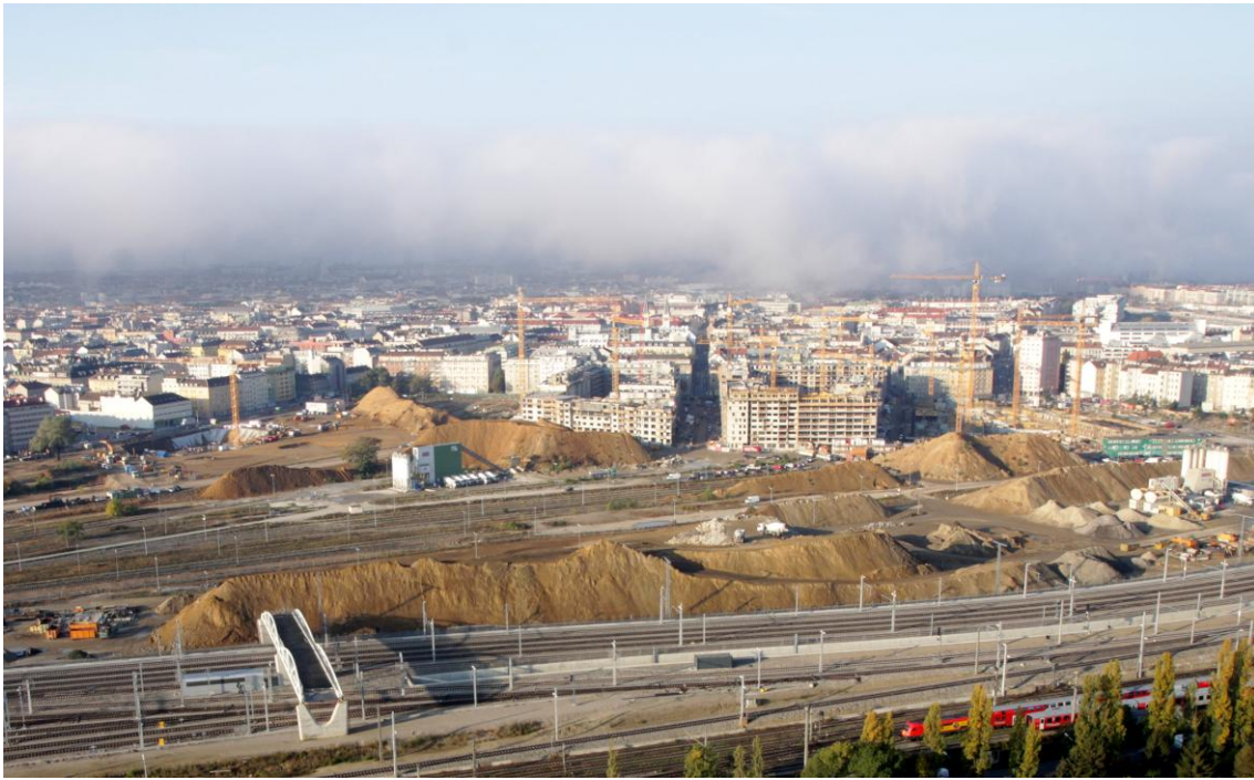
Herbstliche Morgenstimmung im Sonnwendviertel: Der einzelne Kran links steht am großen Baufeld des Bildungscampus, mittig sind die bereits weit fortgeschrittenen Wohnbauten zu sehen. Die riesigen Erdhaufen werden für den Parkunterbau verwendet
