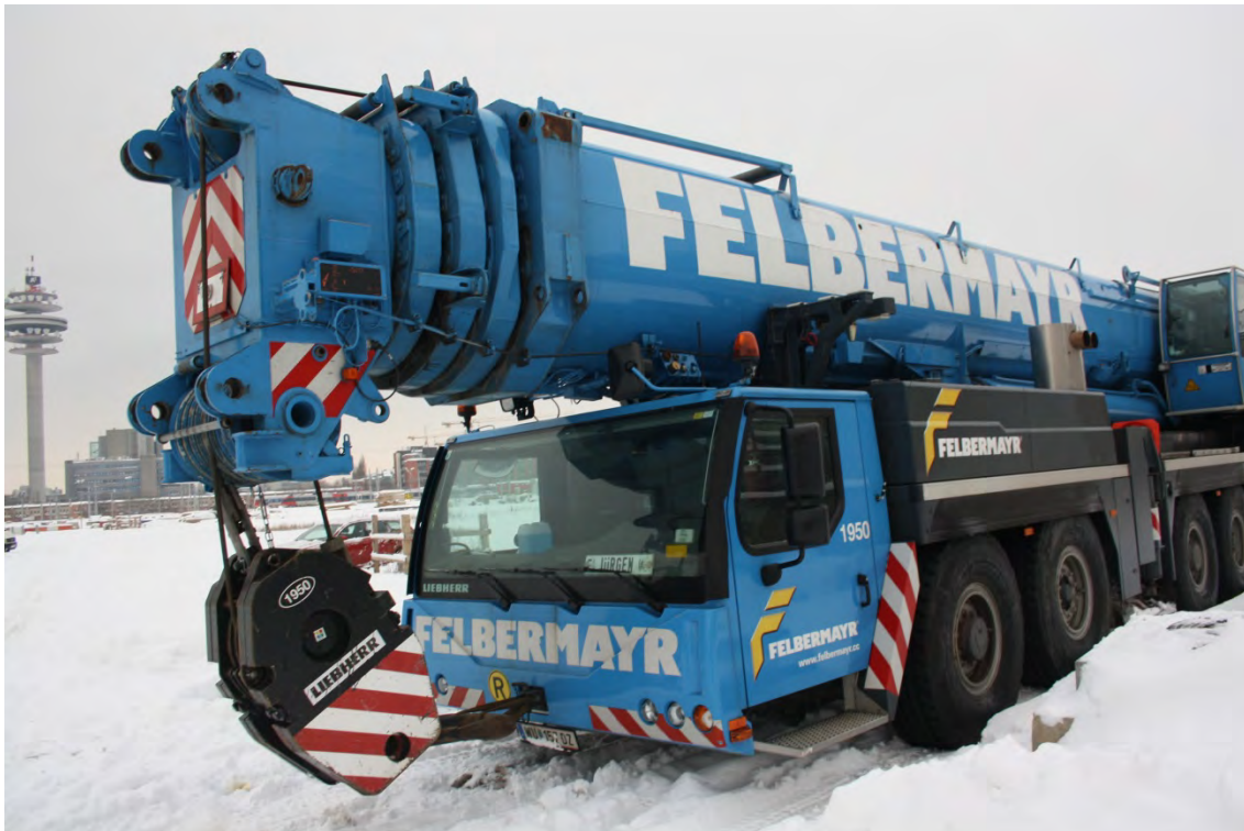
Dieses 84-Tonnen-Ungetüm kam beim Eindecken der Turnhalle am Bildungscampus erfolgreich zum Einsatz
