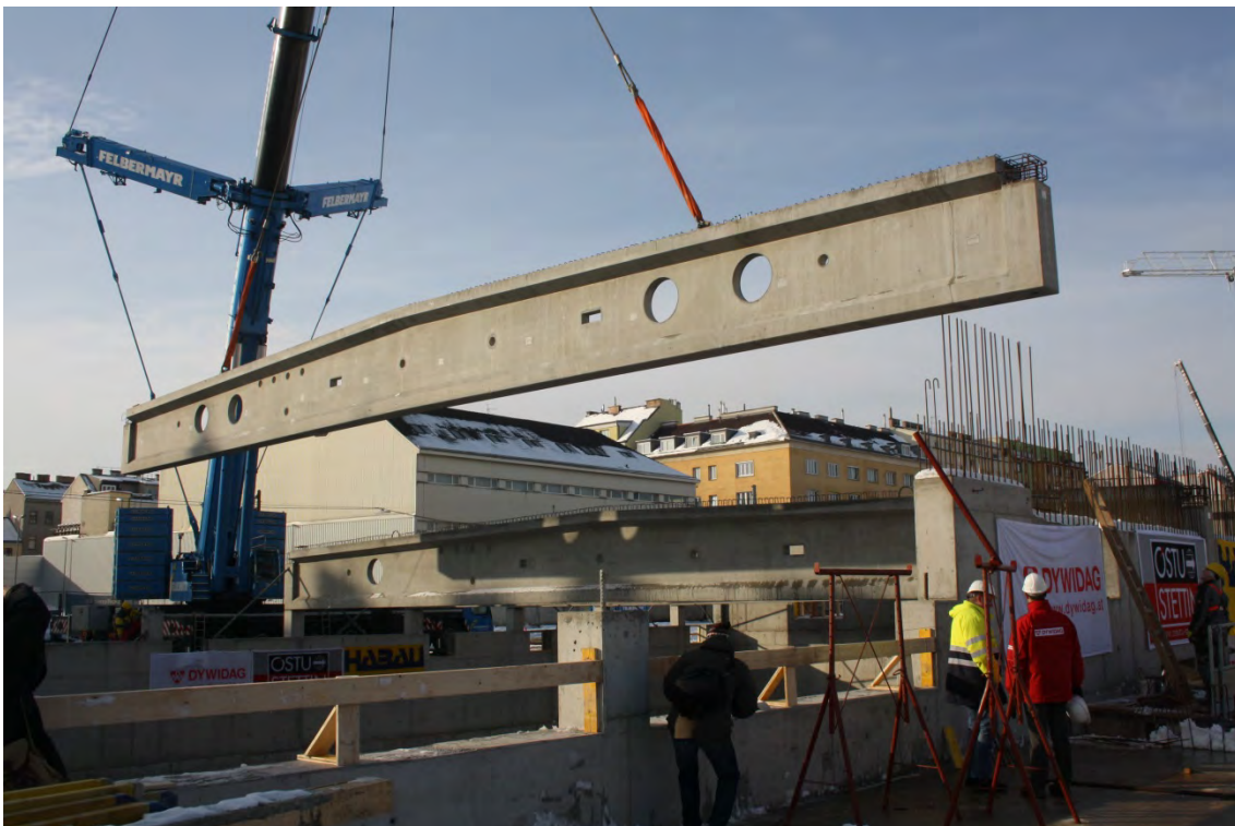
Trotz winterlicher Bedingungen wurde die Eindeckung der Turnhalle plangemäß durchgeführt
