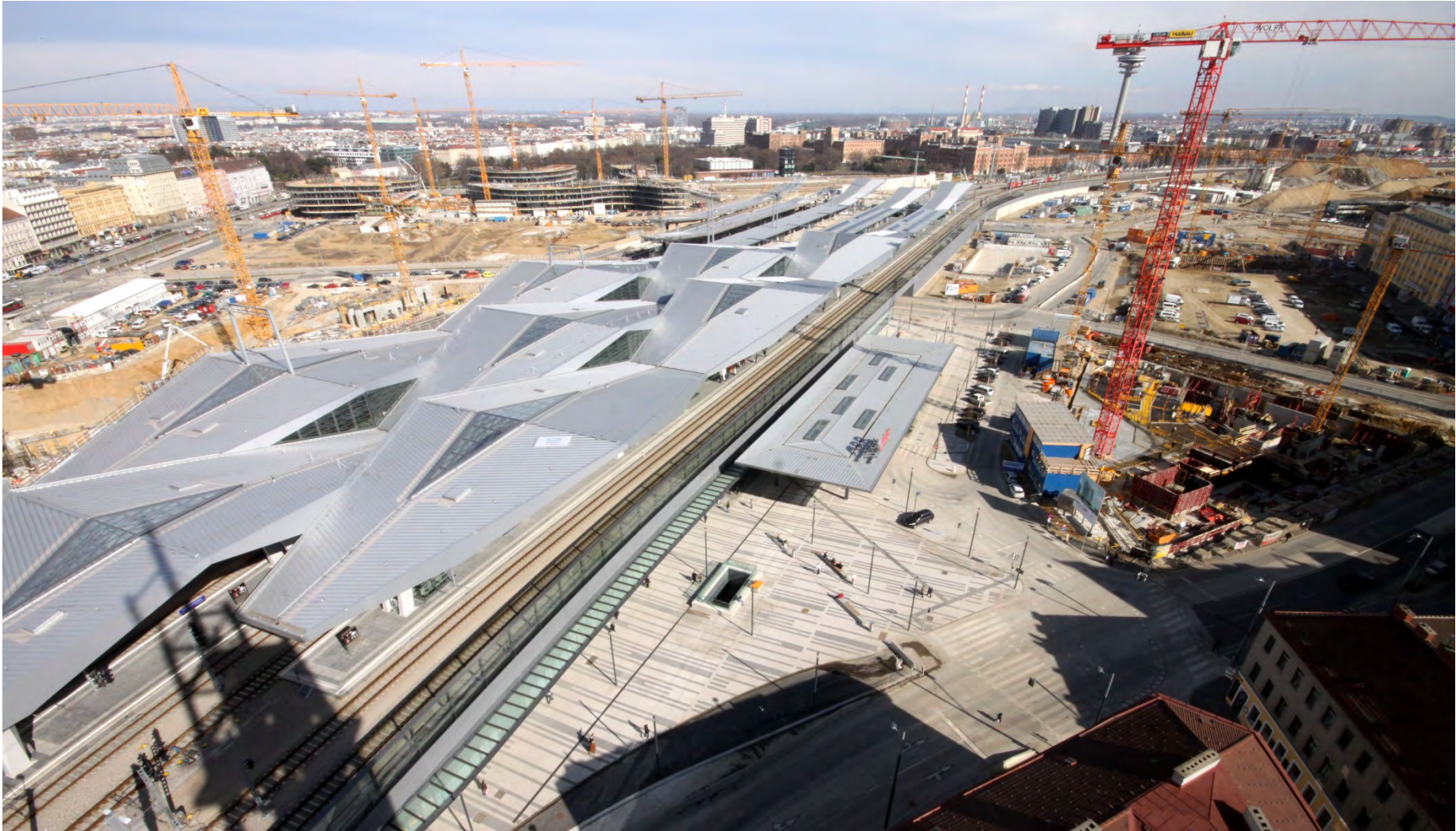
Links hinter dem Rautendach ist die Baugrube der Halle Nord gelegen, links im Hintergrund entsteht das Hauptquartier der Erste Bank, rechts davor sind bereits Teile der Überdachung der Bahnsteige 4 und 5 zu erkennen. Rechts erreicht der Bau des ÖBB-Hauptquartiers zurzeit das Erdgeschoßniveau
