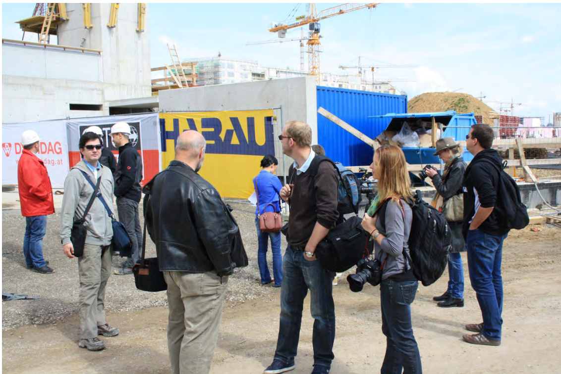
Interessierte Medienvertreter/-innen besichtigen die Fortschritte im Baugeschehen auf der Baustelle des Bildungscampus am Hauptbahnhof Wien
