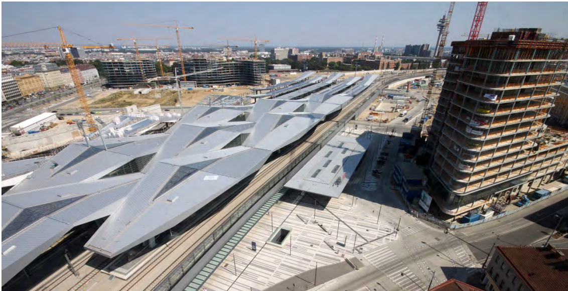
Während das Dach des Hauptbahnhofs Wien zusehends fertig wird, entwächst die ÖBB-Zentrale bereits dem Bildbereich unserer Zeitrafferkamera am bahnorama-Turm. Links hinten ist der Bau des Erste Campus zu erkennen
