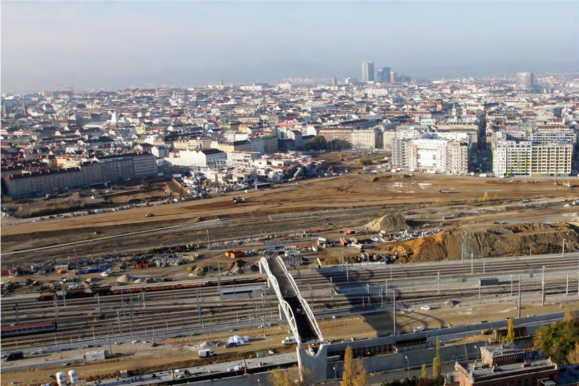
*Links auf mittlerer Höhe wird gerade das Baufeld A.08 ausgehoben, beim Bildungscampus rechts daneben geht der Innenausbau weiter. Die beiden Wohnbaufelder rechts werden derzeit schrittweise besiedelt und im gesamten Vorfeld sind die Erdarbeiten für den Park zu sehen*
