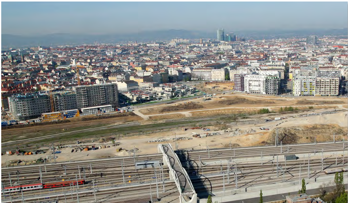
Im Helmut-Zilk-Park werden gerade die Drainage und das Wegenetz angelegt, mittig darüber ist der fertige Bildungscampus zu erkennen. Rechts davon liegt die Baugrube auf C.04, wo 247 Smart-Wohnungen entstehen werden, links vom Campus der Rohbau der Sozialbau auf C.08
