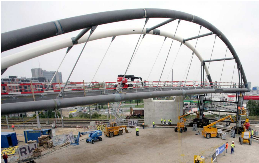
Eindrucksvolle 420 Tonnen schwer und 60 Meter lang ist der erste Bogen des Tragwerks der Südbahnhofbrücke
