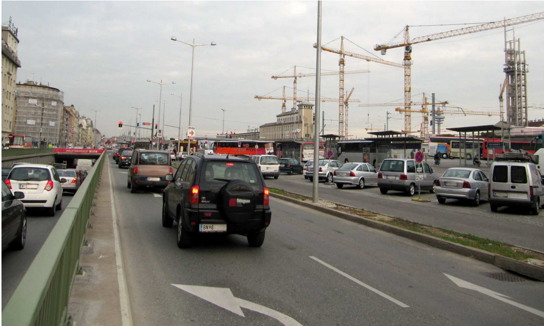
Links ist die Unterführung mit dem Spritzschutz zu sehen, rechts sind die Kräne der Baustelle des Hauptbahnhofs und der bahnorama-Turm erkennbar
