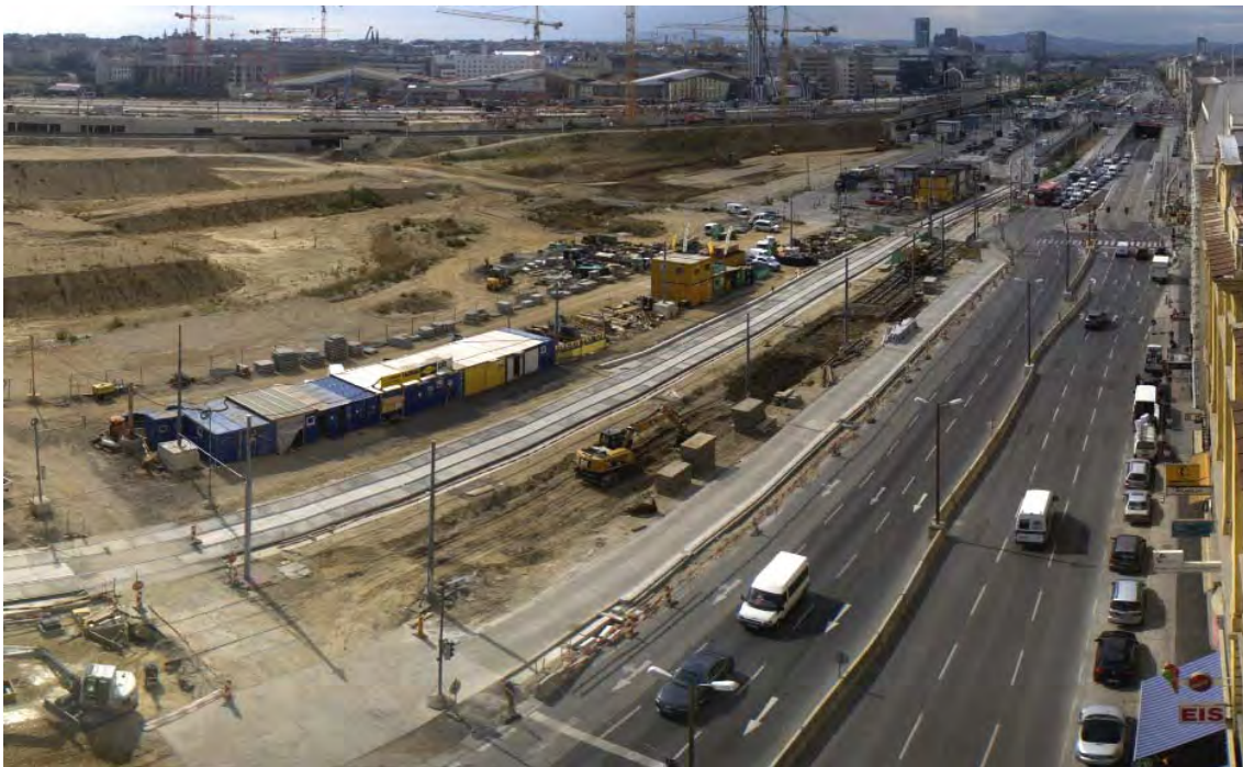
Der Wiedner Gürtel von der Mommsengasse zum Südtiroler Platz zeigt die freigemachten drei - in der Unterführung Südtiroler Platz zwei - Fahrspuren pro Richtung. Vor den Containern ist die neue Straßenbahntrasse der Linien O und 18 zu sehen
