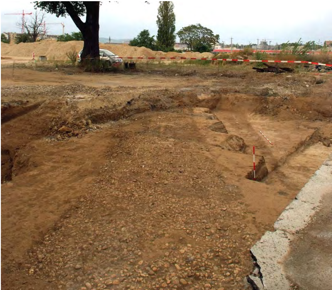
Der Aufschluss (Blick von der Gudrunstraße zum Belvedere) zeigt die Befestigung einer Straße, welche als gerade Verlängerung der Prinz Eugen Straße zu verstehen ist. Rechts davon, zwischen den Fluchtstangen, ist die Verfärbung der Künette der Urselbrunnenwasserleitung zu sehen, welche, vom Laaer Berg kommend, die Brunnen im Belvederegarten speiste
