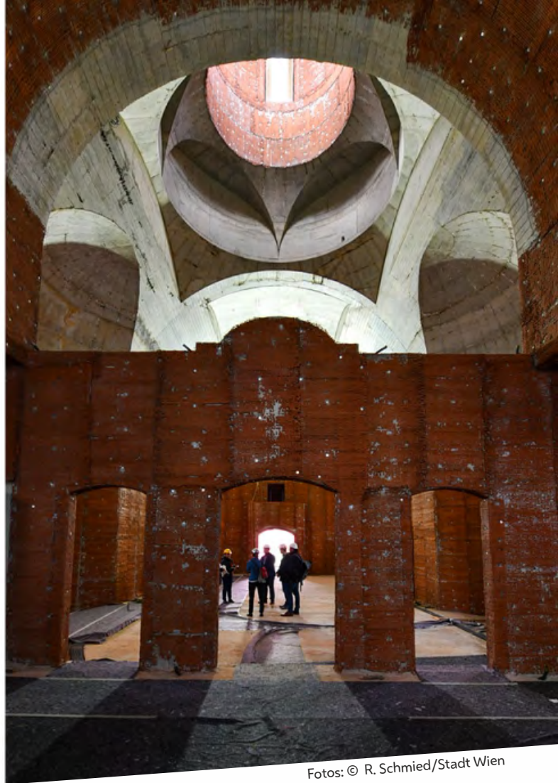
Großes Handwerk: Die Kreuzkuppel wurde händisch betoniert.
