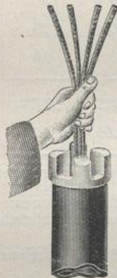
1. das Einziehen der Drähte.
