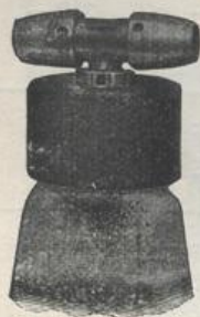
Befestigung eines Verbinders auf Stützisolatoren.
