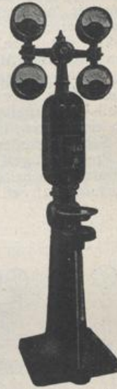
Schaltsäule mit einem Handgriff und einem Regulatorantrieb.
