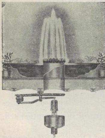
Einrichtung zum selbsttätigen Farbenwechsel der Springbrunnen.
