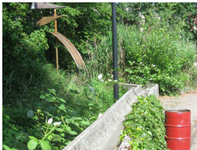
Abb. 76 Offene Rinne zur Regenwasserableitung (Foto: Büro Grimm)
