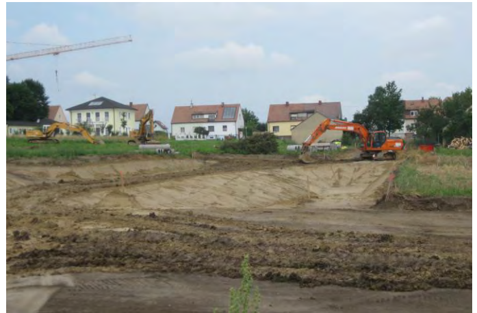
Abb. 60 Retentionsmulde in Bau (Foto: Büro Grimm)
