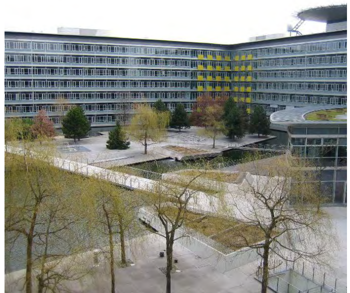
Abb. 90 Wasserbecken im Innenhof (Foto: Büro Adler & Olesch)
