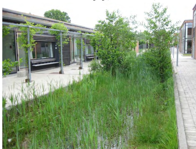
Abb. 106 Mit Erlen bepflanzter Versickerungsbereich (Foto: Büro Grimm)
