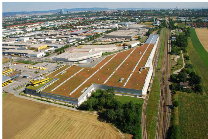
Abb. 59 Briefzentrum Wien, Blick Richtung Norden (Foto: Österreichische Post AG)
