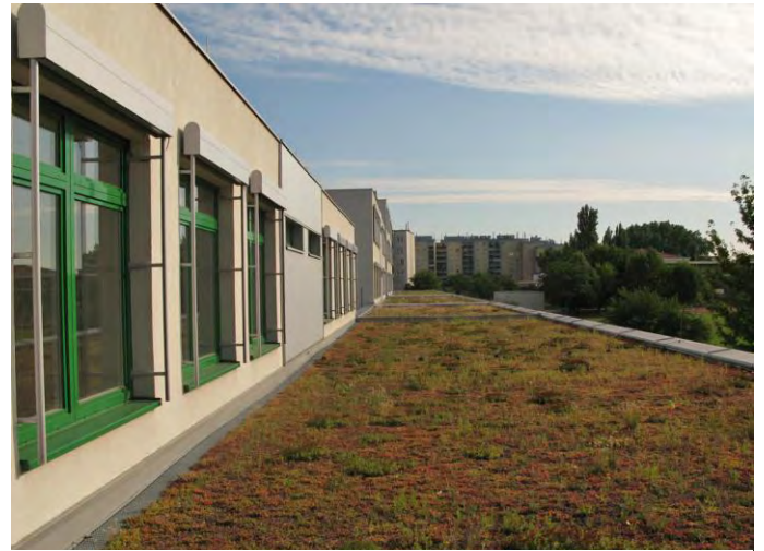
Abb. 56 Extensiv begrüntes Erdgeschoßdach (Foto: Büro Grimm)
