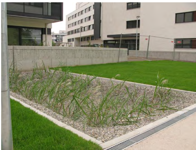
Abb. 16 Mit Gräsern bepflanztes Mulden-Rigole zur Entwässerung der Wegflächen (Foto: Büro Grimm)
