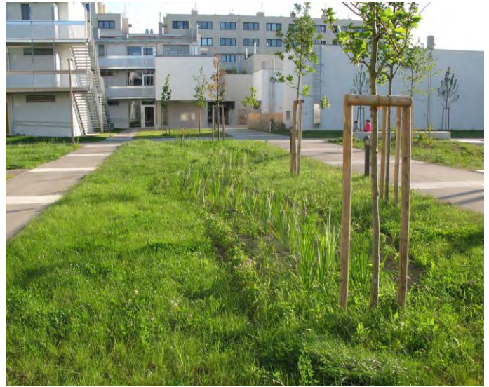
Abb. 11 Schilfbeet zur Versickerung der Oberflächenwässer (Foto: Büro Grimm)
