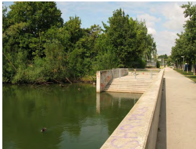
Abb. 27 Blick auf die Treppenanlage, darunter liegen die Sickerschächte (Foto: Büro Grimm)
