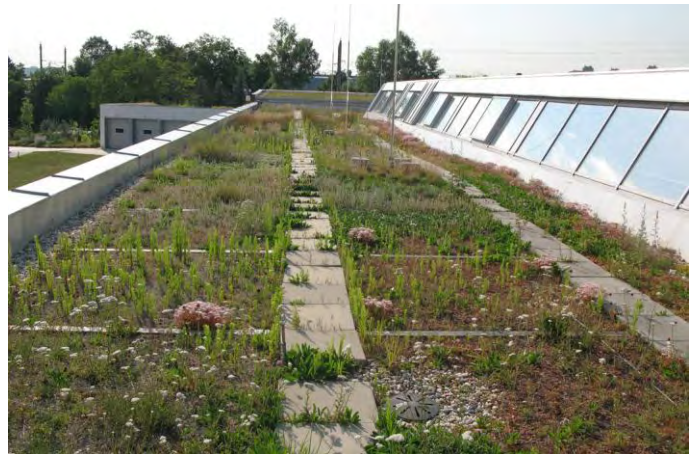
Abb. 31 extensive Dachbegrünung (Foto: Büro Grimm)
