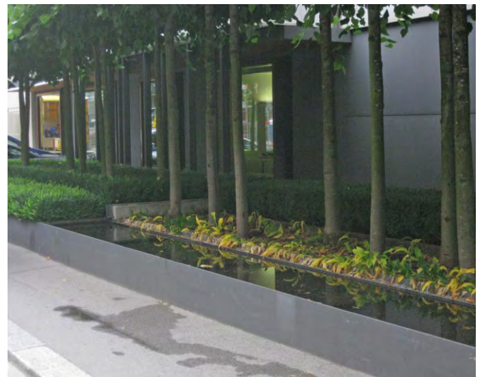
Abb. 100 Wasserbecken mit dahinterliegendem Sickerbereich (Foto: Büro Grimm)
