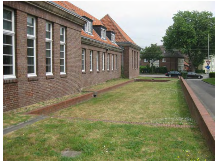
Abb. 70 Retentionsmulde mit Bodenfilter (Foto: Büro Grimm)
