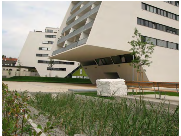
Abb. 14 Mit Gräsern bewachsenes Mulden-Rigole als zentrales Gestaltungselement (Foto: Büro Grimm)
