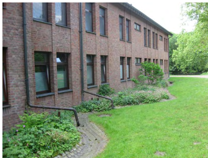
Abb. 83 Ableitung in offenen Mulden (Foto: Büro Grimm)
