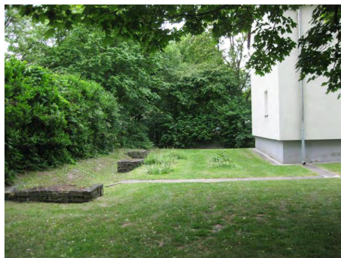
Abb. 78 Rasenmulde als Sickerfläche (Foto: Büro Grimm)
