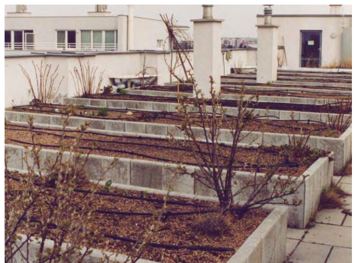
Abb. 26 Hochbeete am Dach in der vegetationsfreien Zeit, Bewässerung mit Brunnenwasser (Foto: Büro Grimm)
