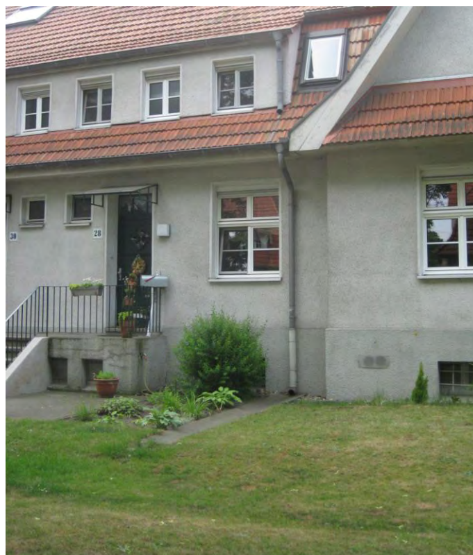
Abb. 74 Ableitung in offenen Rinnen (Foto: Büro Grimm)
