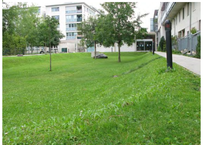
Abb. 3 Versickerungsmulde im nördlichen Hof (Foto: Büro Grimm)
