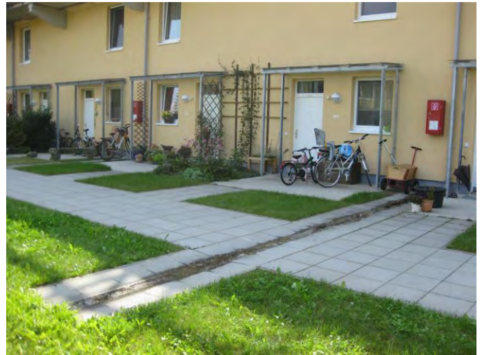
Abb. 63 Ableitung in offenen Rinnen (Foto: Büro Grimm)
