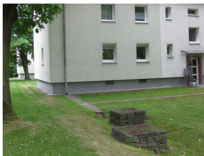
Abb. 79 Rasenmulde als Sickerfläche, Gabione als Gestaltungselement (Foto: Büro Grimm)
