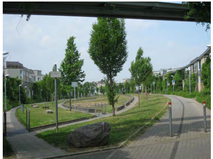
Abb. 82 Zentrale Versickerungsmulde und aufgeständertes Rinnensystem (Foto: Büro Grimm)
