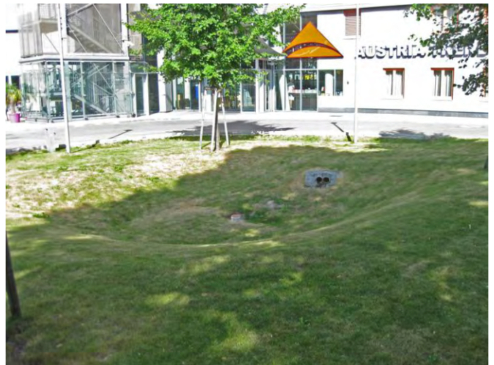
Abb. 8 Sickermulde für Oberflächenwässer mit unterirdischen Sickerschächten für Dachwässer (Foto: Büro Grimm)
