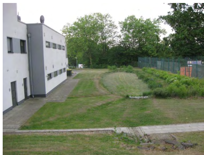
Abb. 81 Filtermulde für Parkplatzabwässer (Foto: Büro Grimm)
