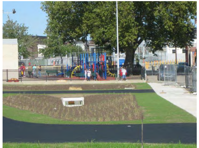
Abb. 112 frisch bepflanzte Retentionsmulde (Foto: Büro Grimm)
