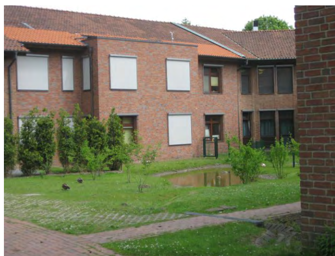
Abb. 85 Regenwassergespeicher Teich (Foto: Büro Grimm)
