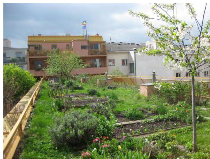
Abb. 50 Intensiv begrünte Dachfläche mit Nutzbeeten (Foto: Büro Grimm)
