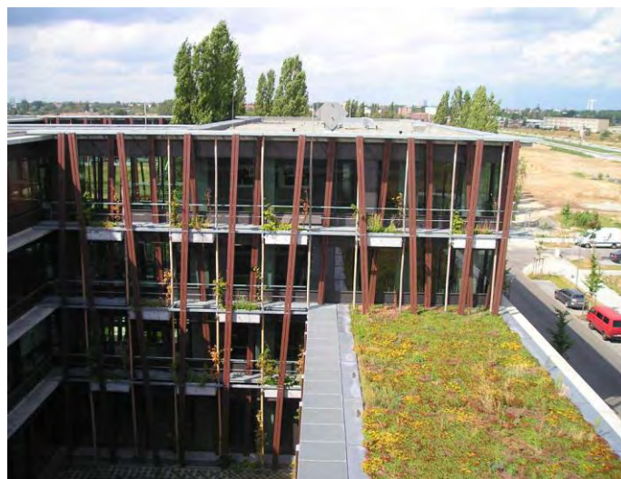
Abb. 89 Begrünte Fassade kurz nach Fertigstellung - 2004, Gründach im Vordergrund (Foto: Marco Schmidt)
