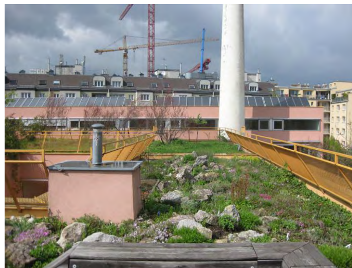
Abb. 49 Intensiv begrünte Dachflächen (Foto: Büro Grimm)
