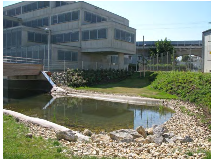
Abb. 33 Retentionsteich mit dahinter liegendem Versickerungsbereich (Foto: Büro Grimm)
