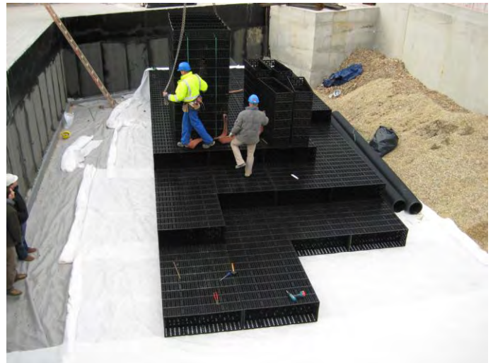
Abb. 41 Einbau Sickerrigole (Foto: CUUBUUS architects)
