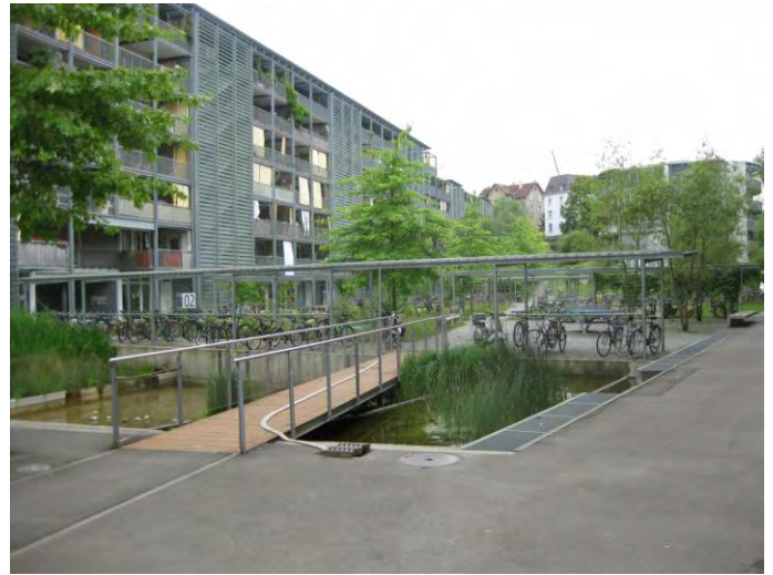
Abb. 102 Retentionsbecken (Foto: Büro Grimm)
