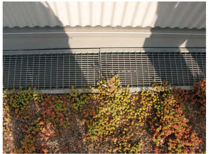
Abb. 57 Detail Entwässerung (Foto: Büro Grimm)
