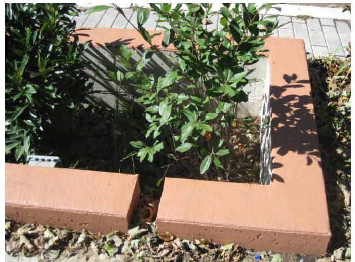
Abb. 111 Detail Einlauf Tiefbeet (Foto: Büro Grimm)
